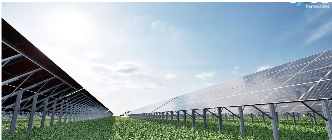
Figura 4-2: Struttura di sostegno dei moduli fotovoltaici
