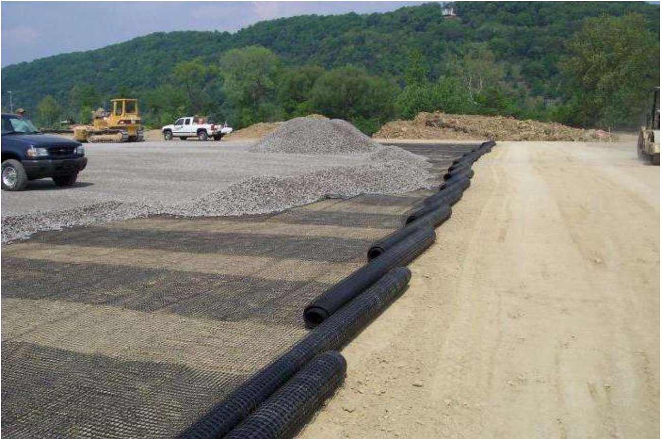
Figura 45_immagine esemplificativa (fonte google) dell'applicazione di geogriglia di rinforzo alla base del rilevato
