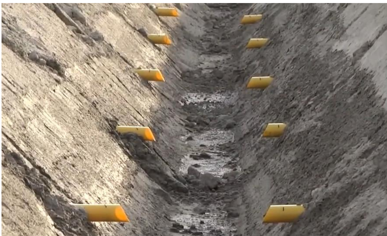
Figura 3-4. Esempio di scarico dei dreni elementari in vaso di laminazione innestati in tronchetti in PVC.
