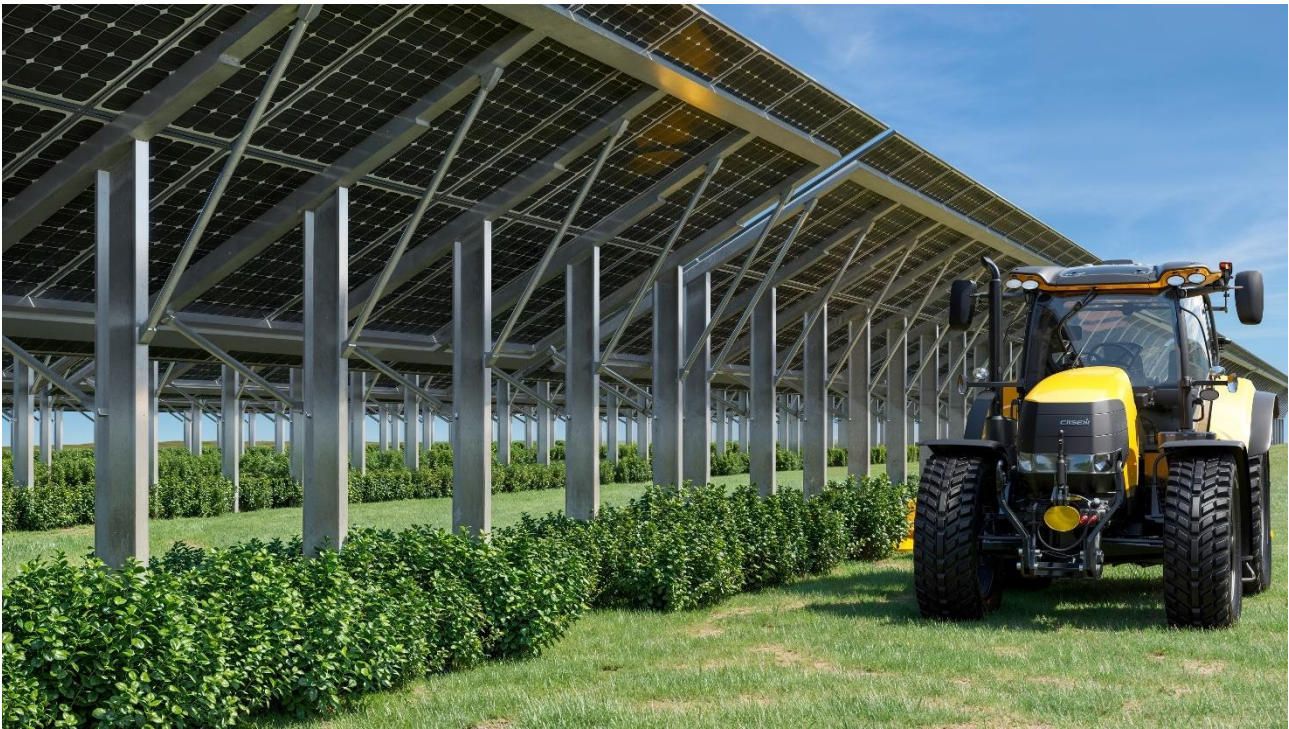
Figure 3-3: Struttura di sostegno e passaggio trattore
