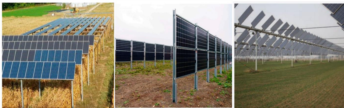
Figura 3.2: Esempi di differenti soluzioni agrivoltaiche: impianti fissi (Legambiente, 2020); moduli verticali; sistemi di inseguimento (Toledo e Scognamiglio, 2021); Sistema Agrovoltaco® ( https://remtec.energy/agrovoltaco ).
