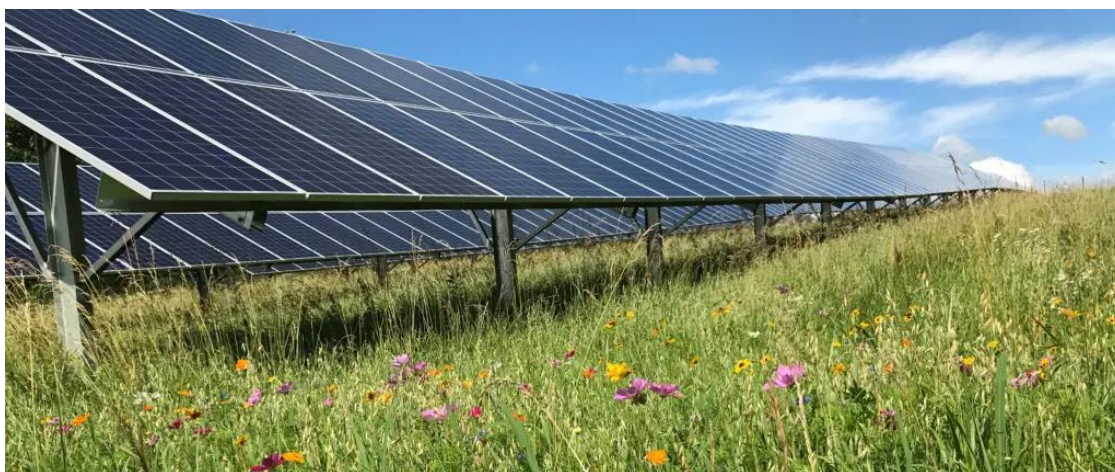
Figura 3.5: Erbaio coltivato al di sotto dei pannelli fotovoltaici Fonte: https://hypergeometric.files.wordpress.com/2020/10/trackers_bee-the-change_mike_kiernan_hero.jpg?w=1024 .
