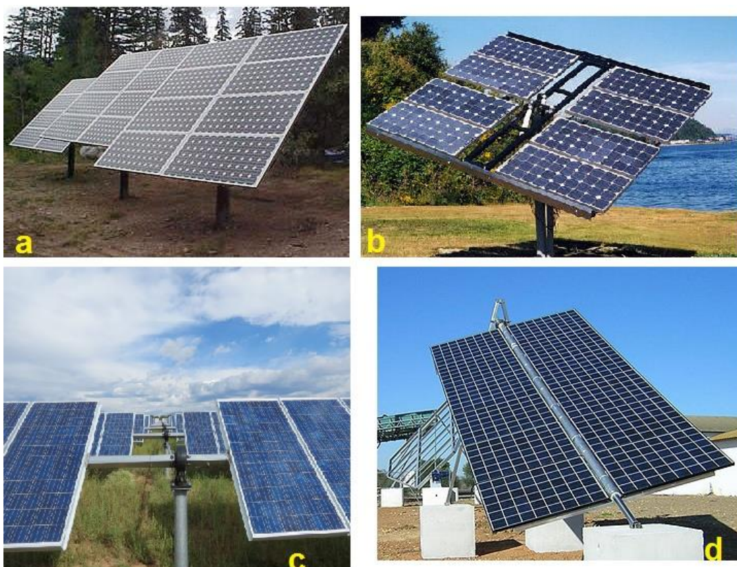
Figura 36 - Sistemi ad inseguimento: a) inseguitore di tilt, b) inseguitore di azimut, c) inseguitore di rollio, d) inseguitore ad asse polare.
