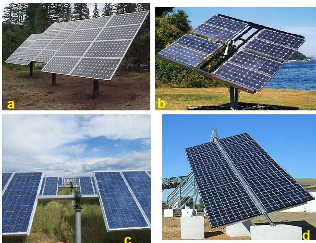
Figura 38 - Sistemi ad inseguimento: a) inseguitore di tilt, b) inseguitore di azimut, c) inseguitore di rollio, d) inseguitore ad asse polare.
