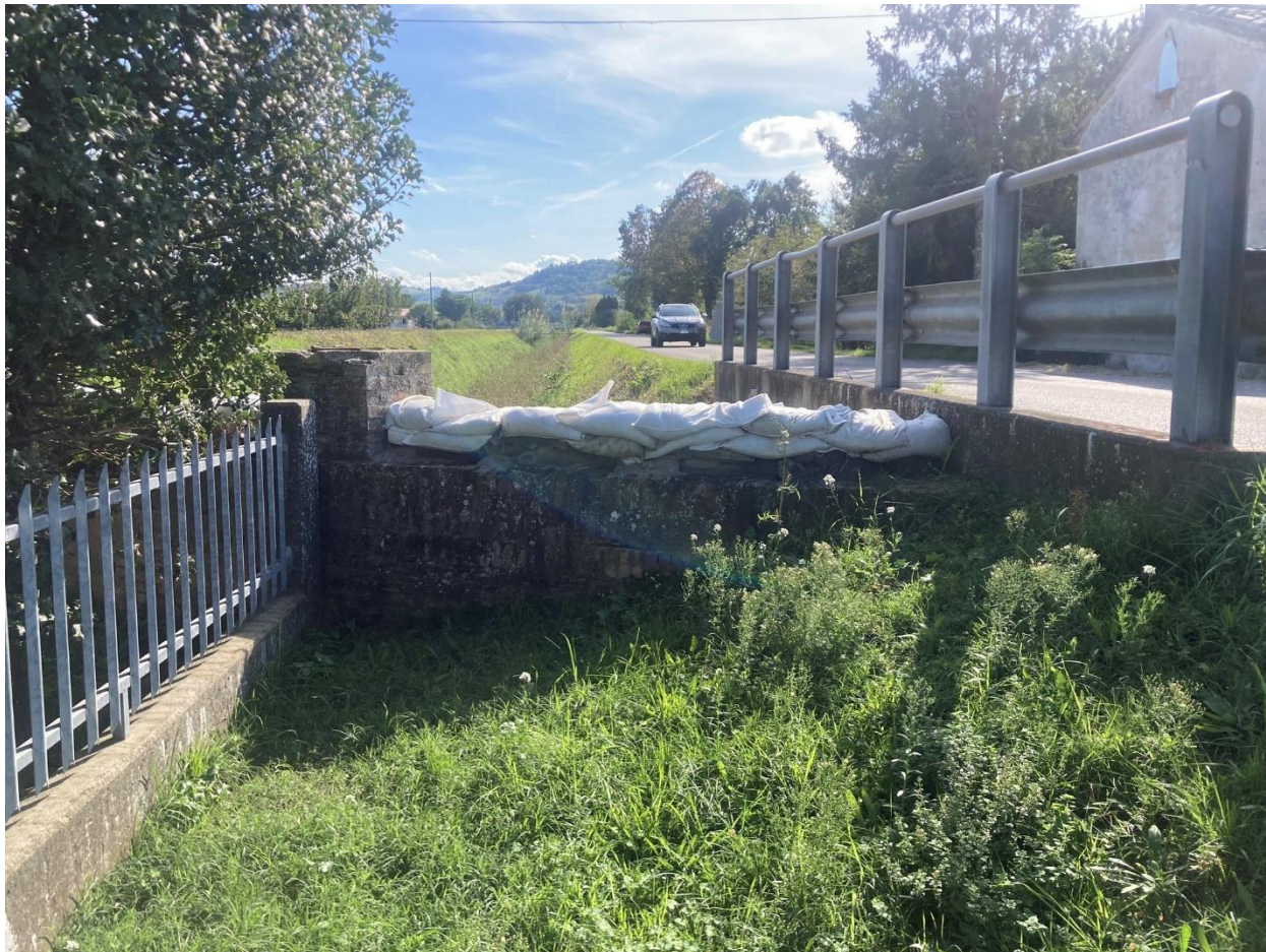
Figura 38 – Particolari delle difese in caso di piena con sacchetti di sabbia
