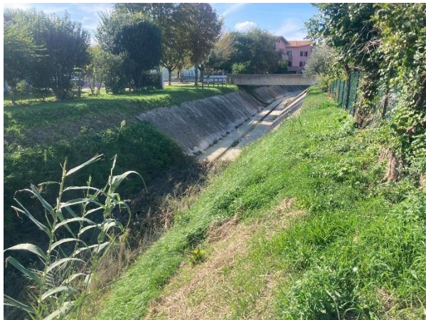
Figura 7 – immagini del tratto rivestito prima del tombamento
