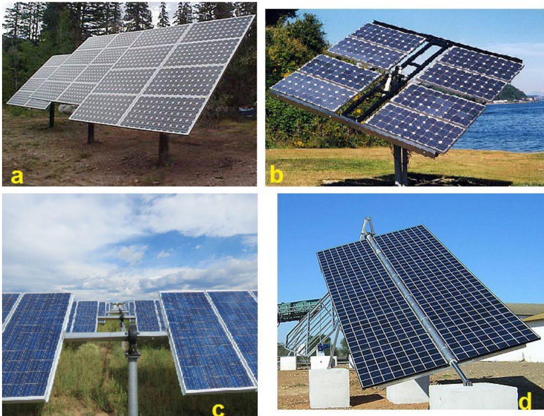
Figura 45 - Sistemi ad inseguimento: a) inseguitore di tilt, b) inseguitore di azimut, c) inseguitore di rollio, d) inseguitore ad asse polare.
