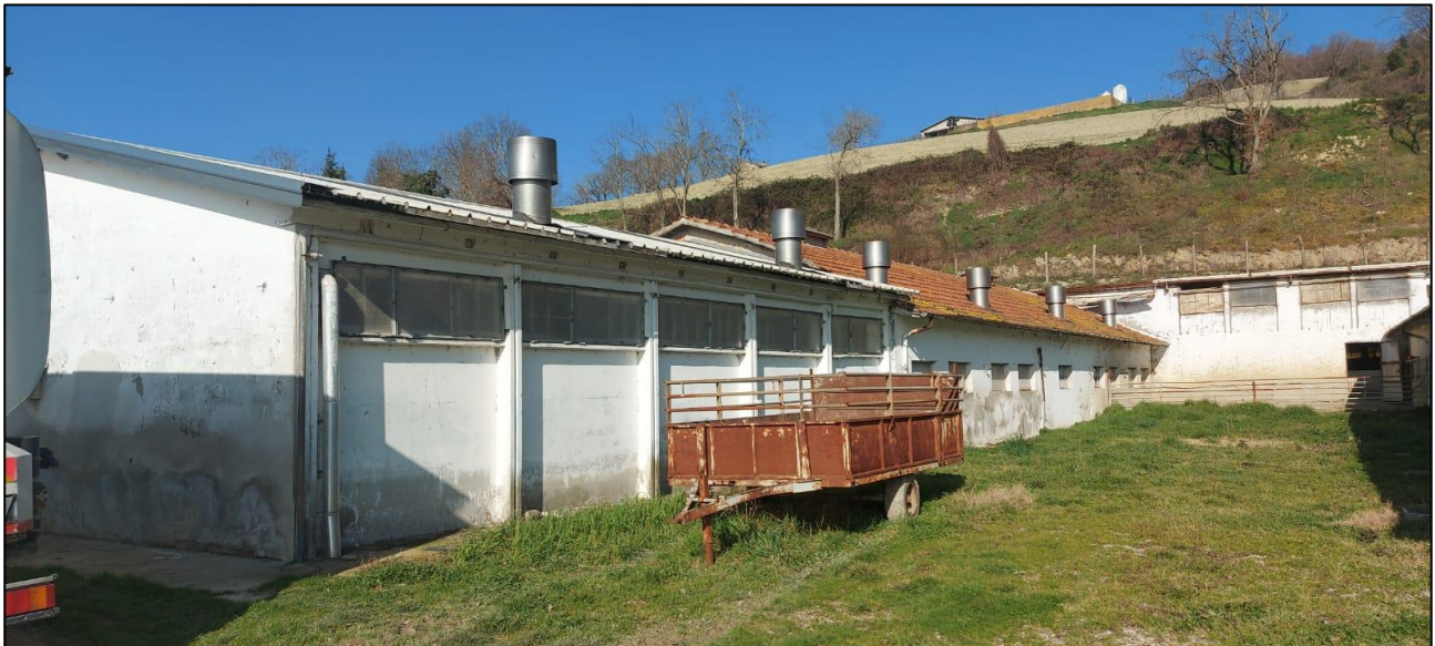
Ventilatori a camino installati su uno dei capannoni esistenti
