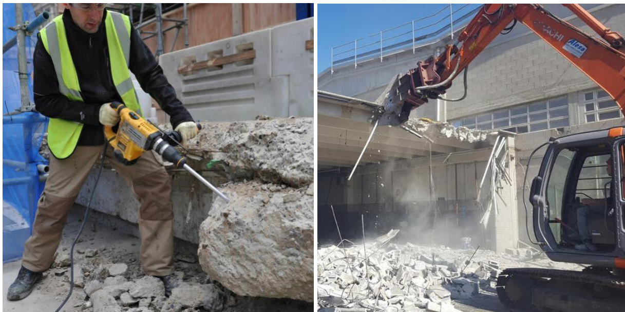
Figura 2-154 - Demolizione di calcestruzzo armato con martello manuale (a sx) e con l'ausilio di mezzi meccanici (a dx)
