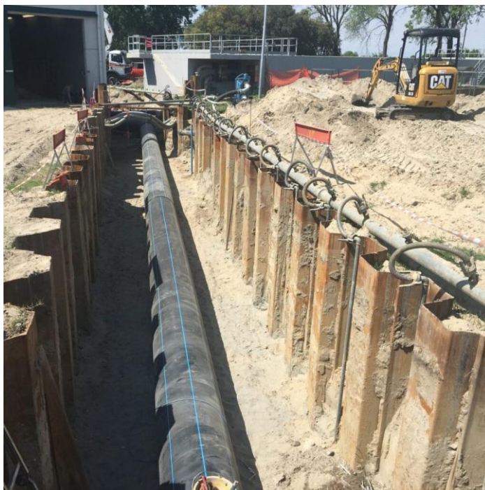
Figura 19 - Esempio di utilizzo di wellpoint in una trincea scavata fra due palancole. Immagine tratta da Web 2
