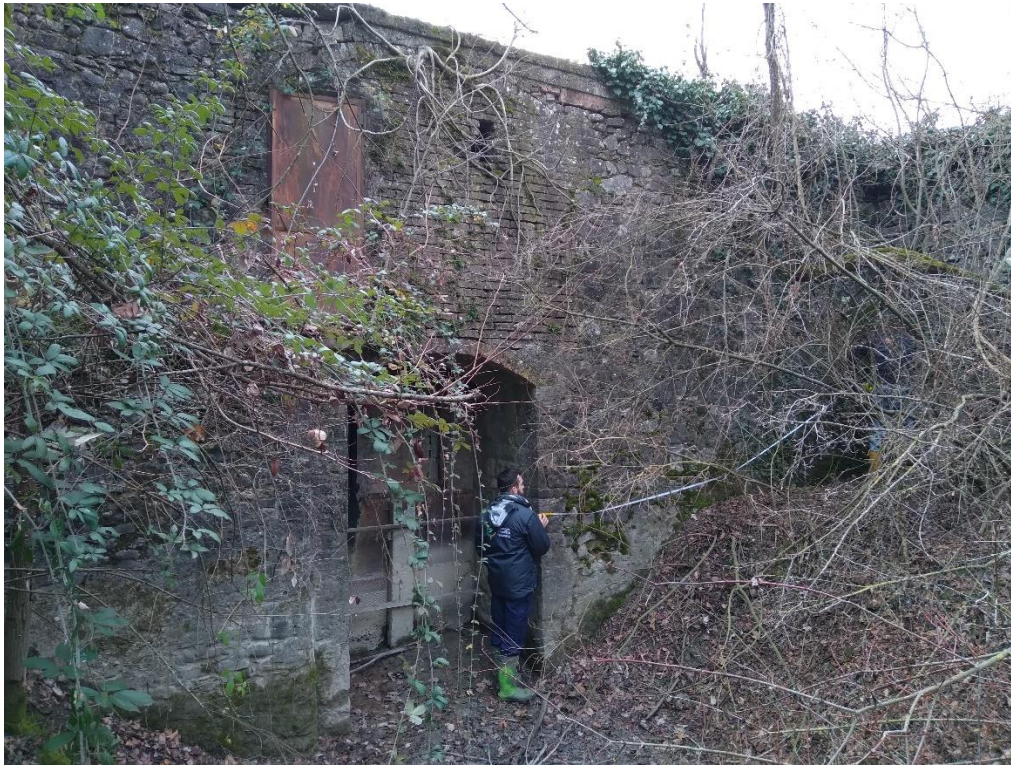
Figura 37: Opera di presa esistente, vista da valle, partenza Canale del Mulino
