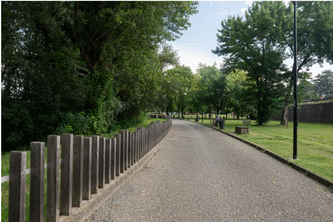
Figura 47: Tratto di nuova posa della condotta. Area verde pubblico.
