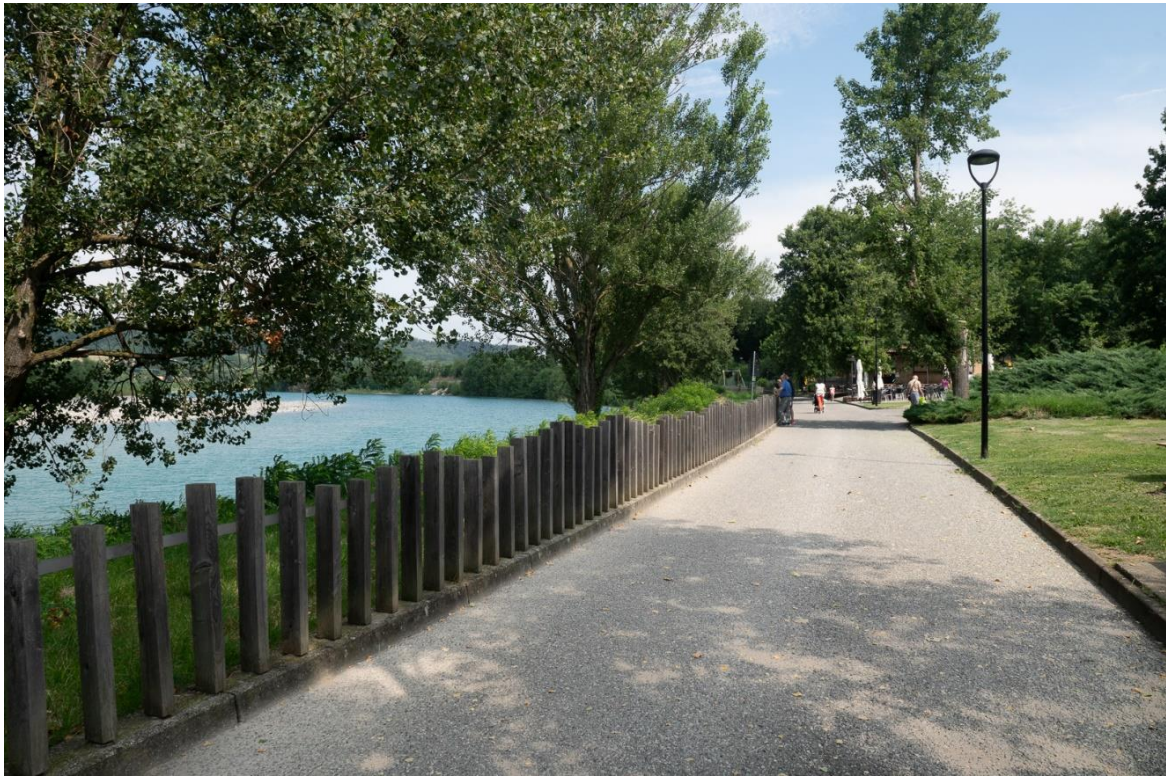
Figura 49: Tratto di nuova posa della condotta. Area verde pubblico.
