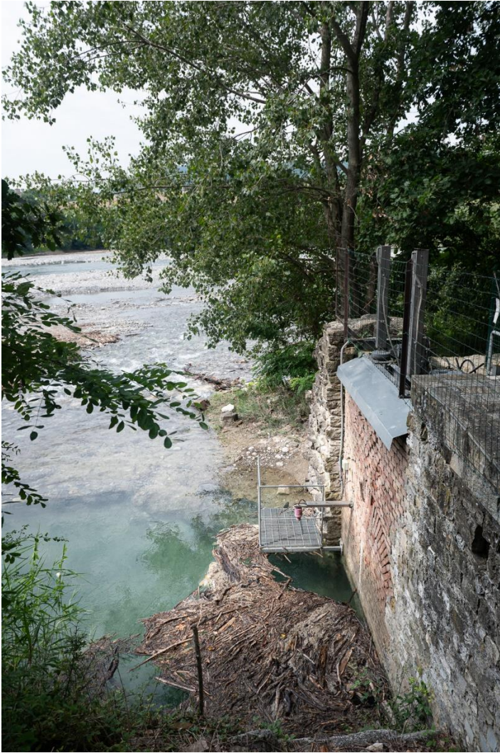
Figura 55: Opera di presa esistente Sant'Agata.
