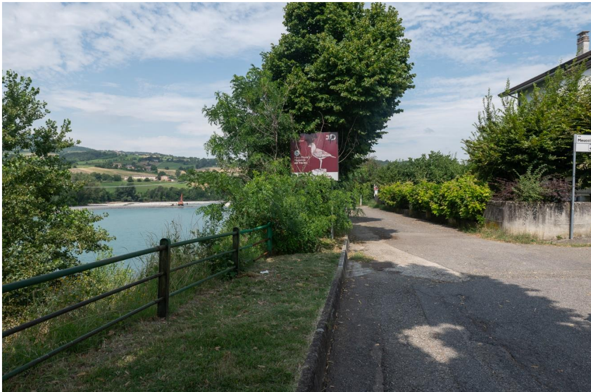
Figura 52: Tratto di nuova posa della condotta. Particolare strada di monte, curva delle rive.
