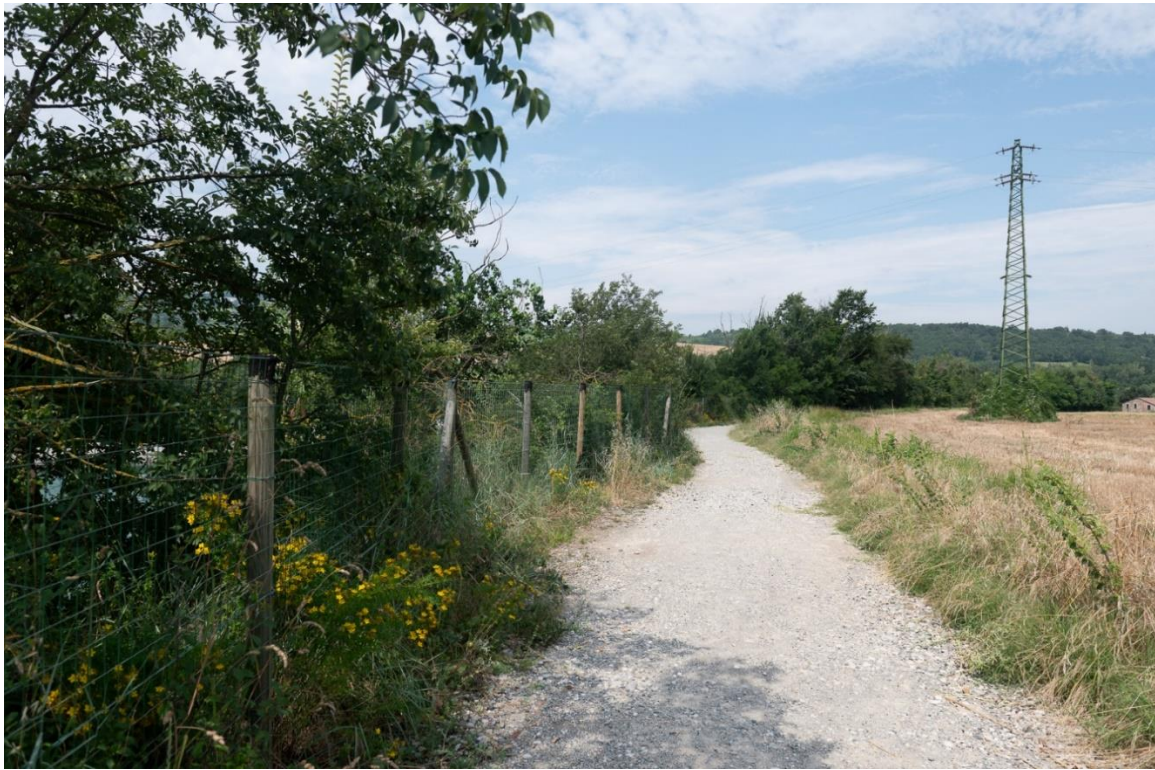
Figura 53: Tratto di nuova posa della condotta. Particolare pista rurale di accesso alla presa Sant'Agata.
