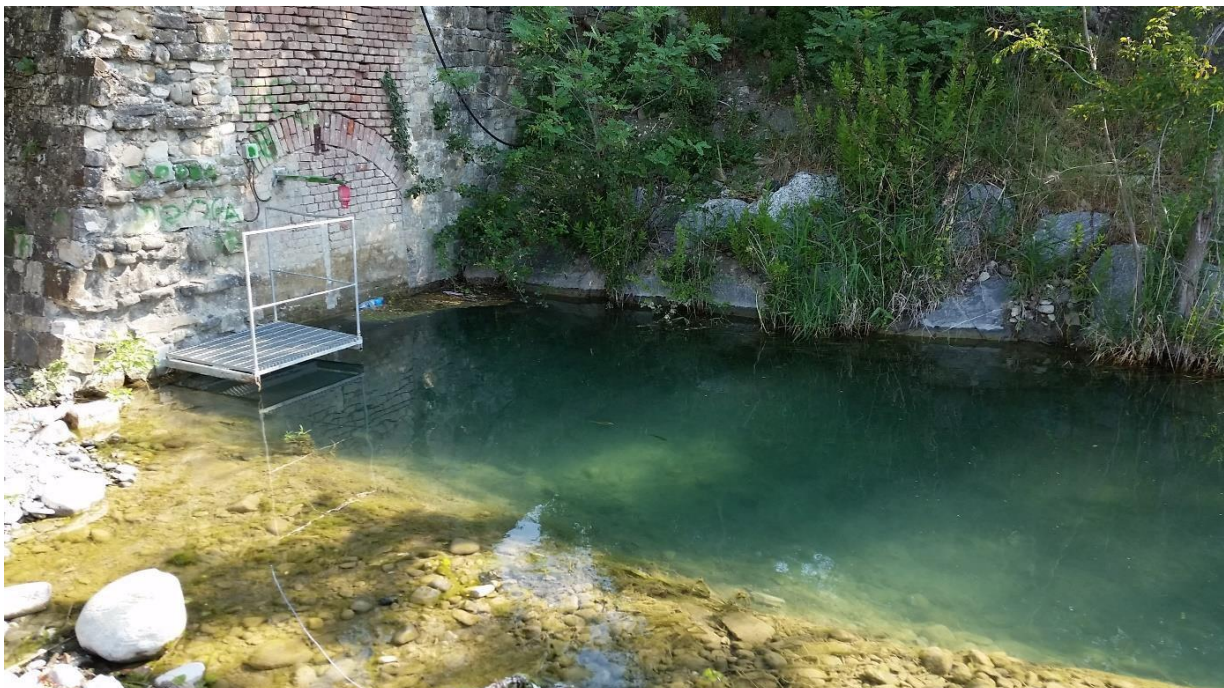
Figura 5: opera di presa esistente del Rivo Villano durante il periodo irriguo.
