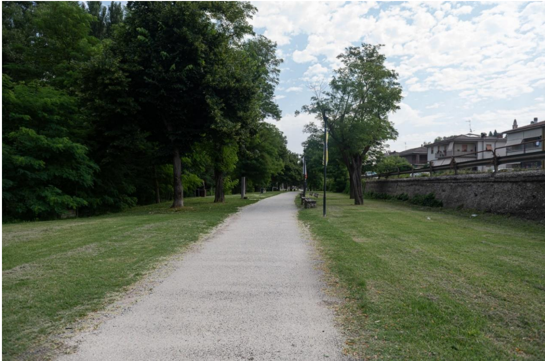
Figura 44: Tratto di nuova posa della condotta. Area verde pubblico.
