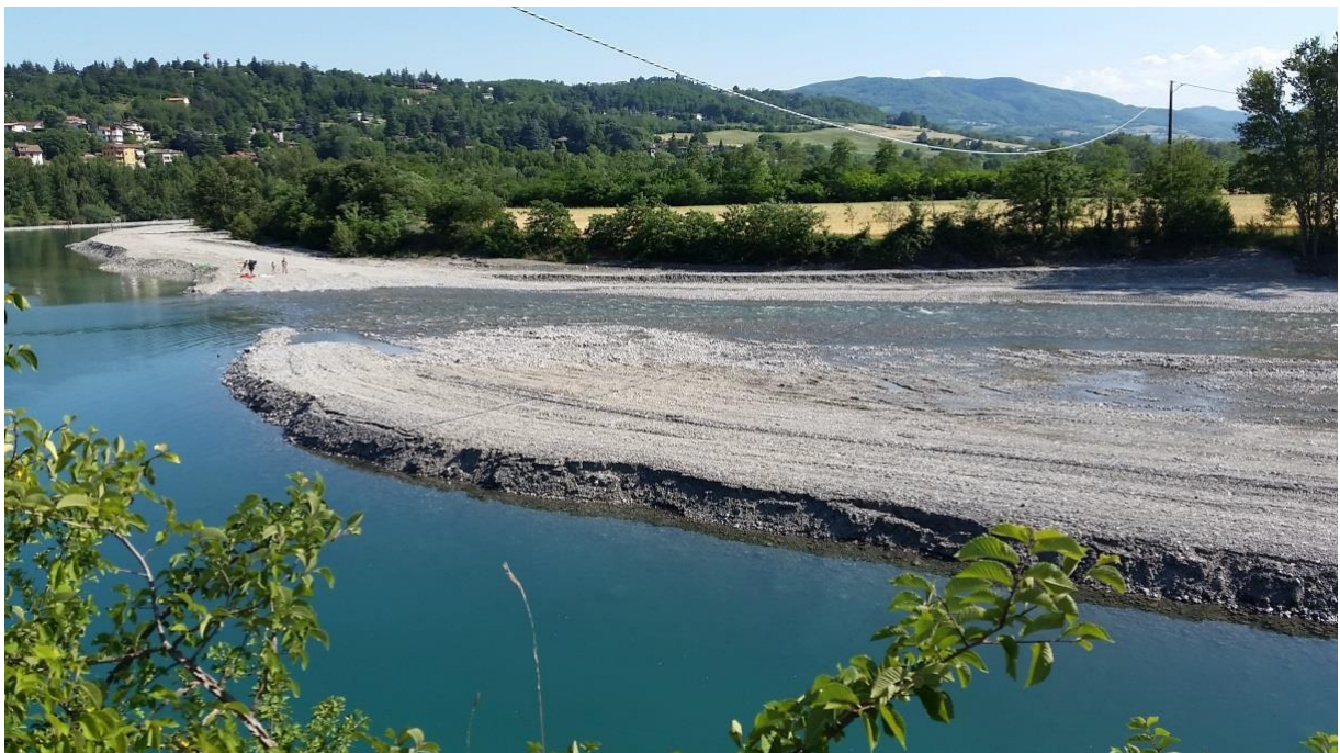
Figura 9: argine in ghiaia per convogliare le acque verso l'opera di presa del Rivo Villano.
