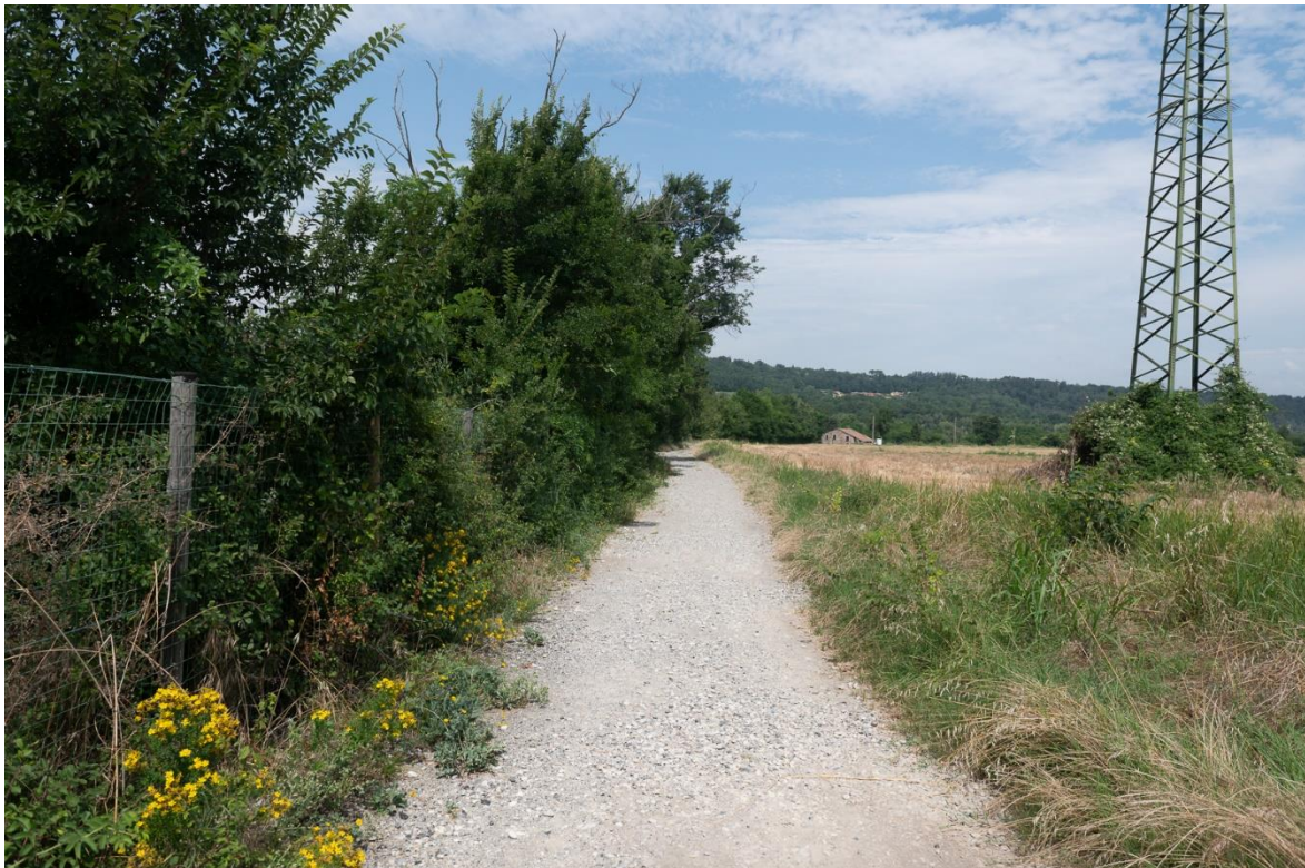
Figura 54: Tratto di nuova posa della condotta. Particolare pista rurale di accesso alla presa Sant'Agata.
