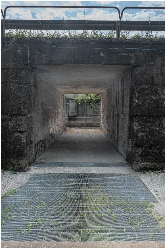
Figura 46: Particolare del sifonamento Rio Merdaro.
