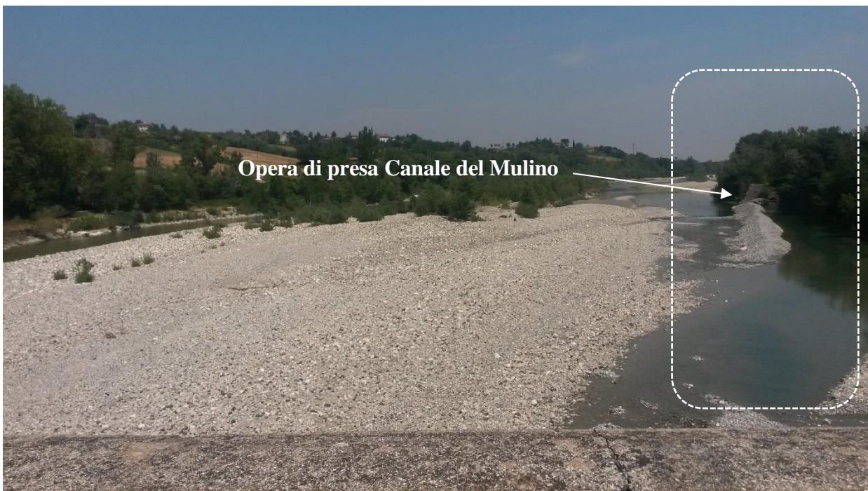
Figura 30: Arginatura in ghiaia per alimentare la presa del Canale del Mulino di Rivergaro (luglio 2015).
