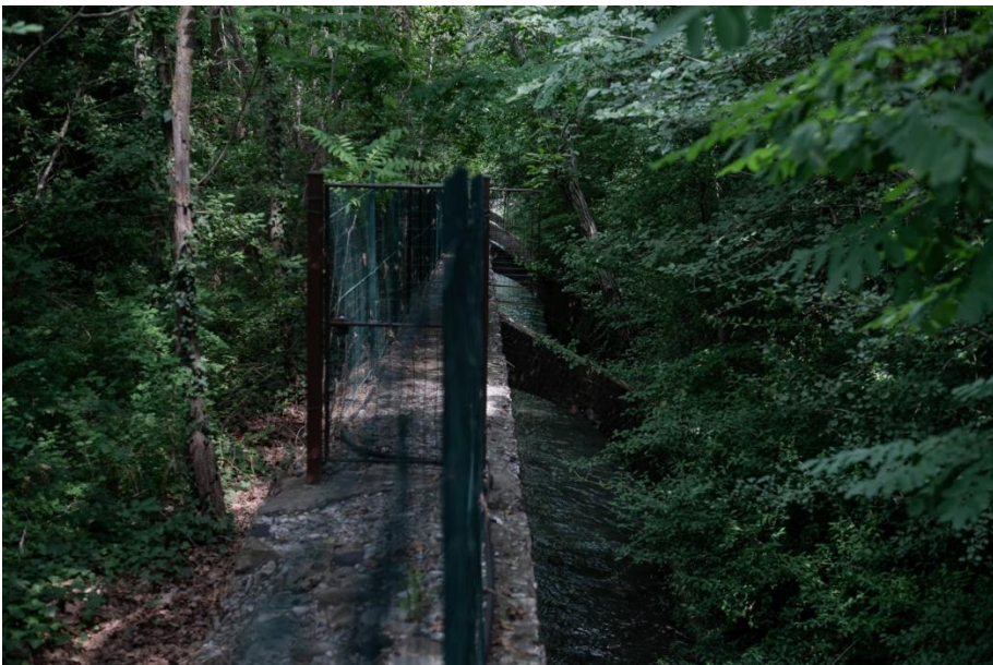
Figura 56: Punto di restituzione della condotta nel Rivo Villano, a valle dell'attuale opera di presa Sant'Agata.
