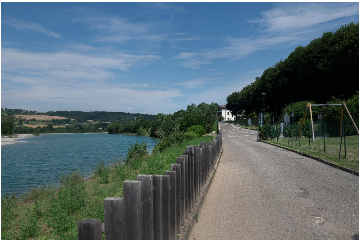
Figura 50: Tratto di nuova posa della condotta. Area verde pubblico.
