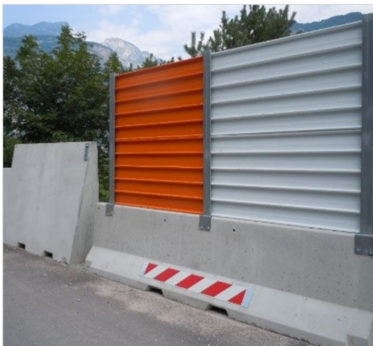
Figura 18 - Esempio di barriera mobile altezza 2 m montata su basamento in cls
