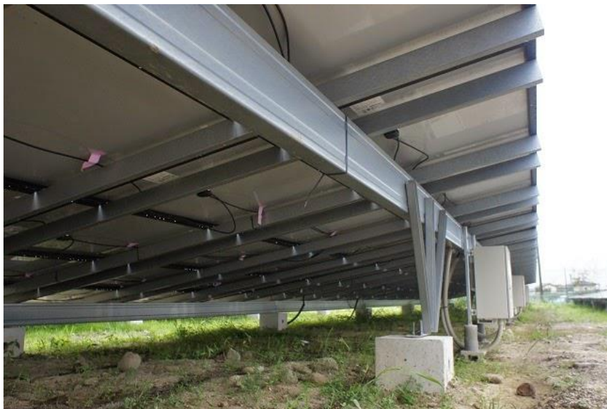
Figura 34: Tipologico fondazione zavorre in calcestruzzo
