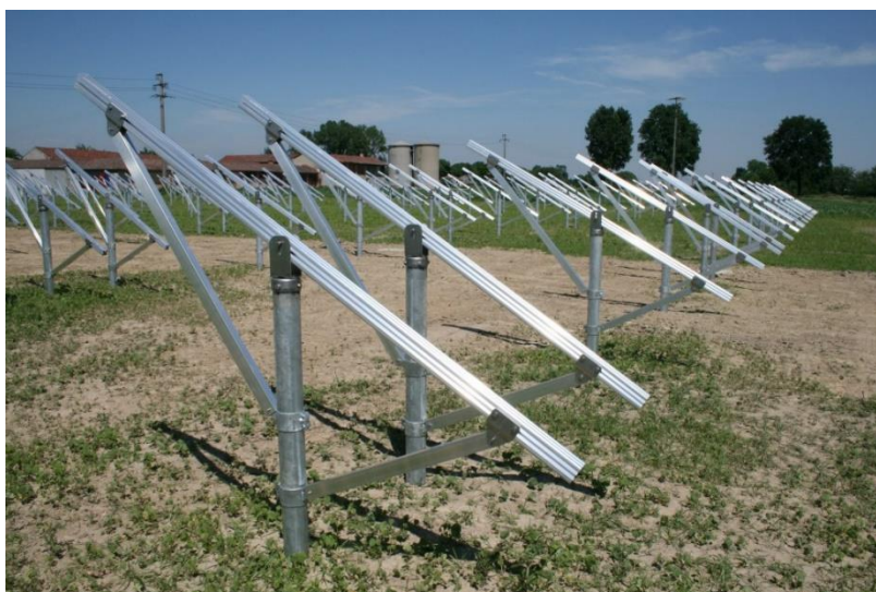
Figura 33: Tipologico fondazione pali infissi
