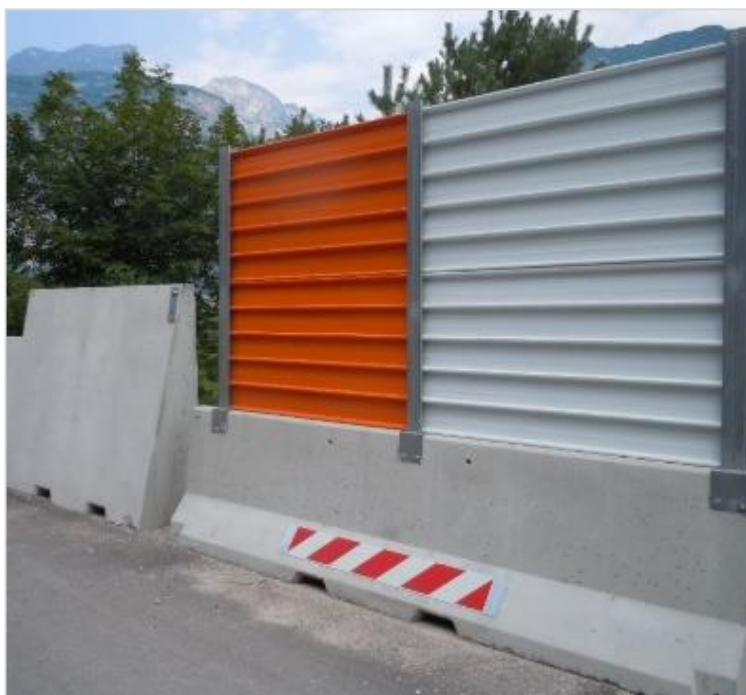
Figure 7-64: Esempio di barriera mobile altezza 2 m montata su basamento in cls
