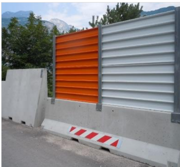
Figura 14 - Esempio di barriera mobile altezza 2 m montata su basamento in cls
