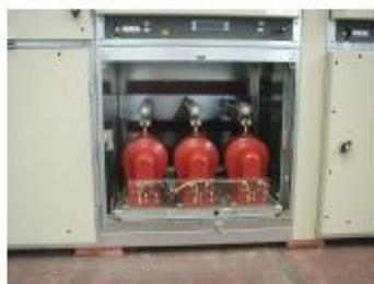
Cella TV in posizione di sezionato. VT cubicle in disconnected position.
