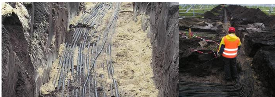
Figura 3: Conduttori AC (lato BT)
