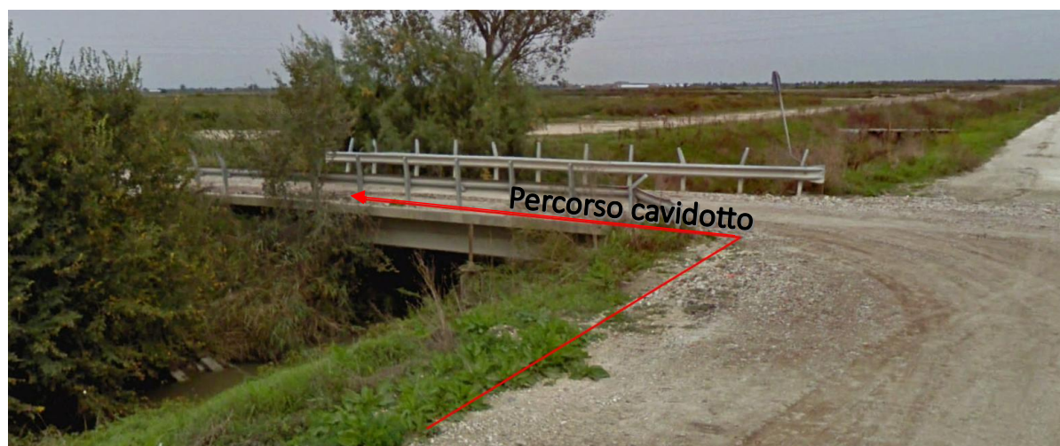
Figura 34: Interferenza con il Cavo Canalazzo all'altezza di via Valle Acquosa
