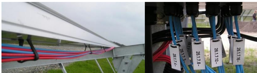
Figura 80: Conduttori DC (lato BT)
