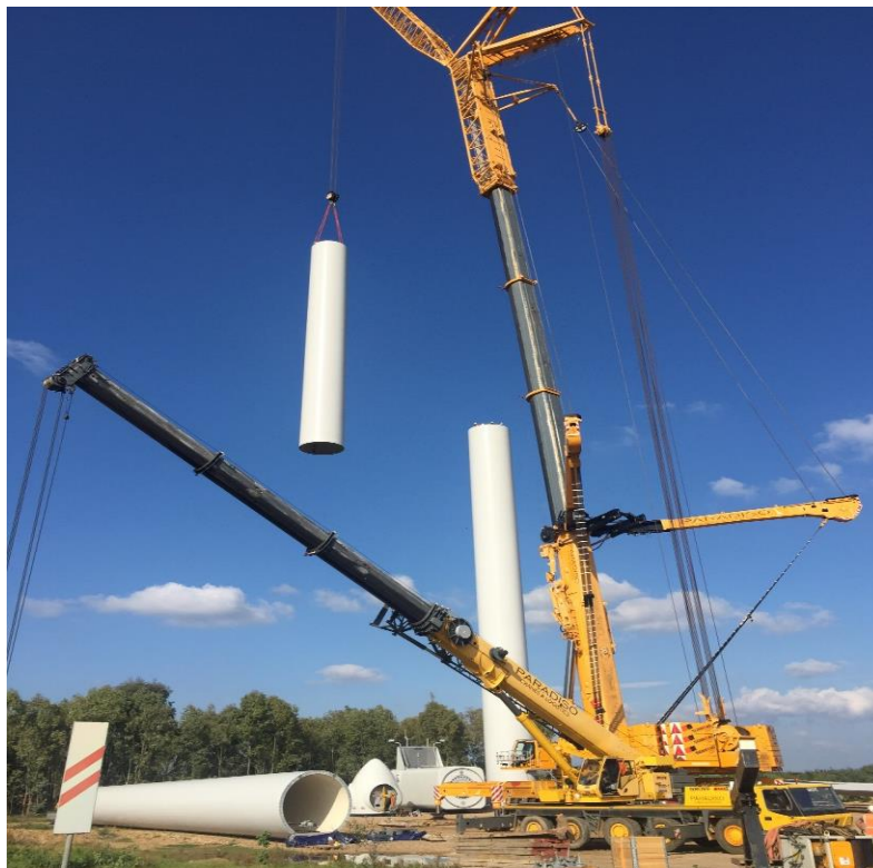
Fig. 16: montaggio tronco di torre intermedio
