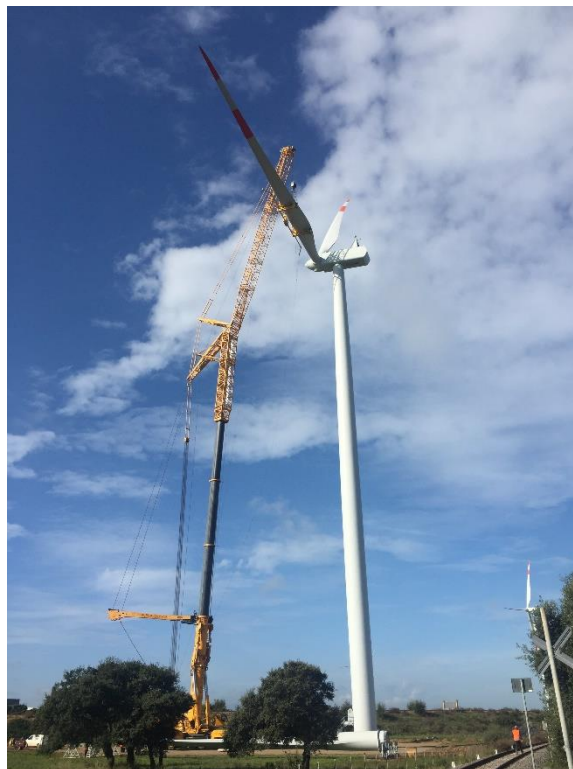
Fig. 18: montaggio pale
