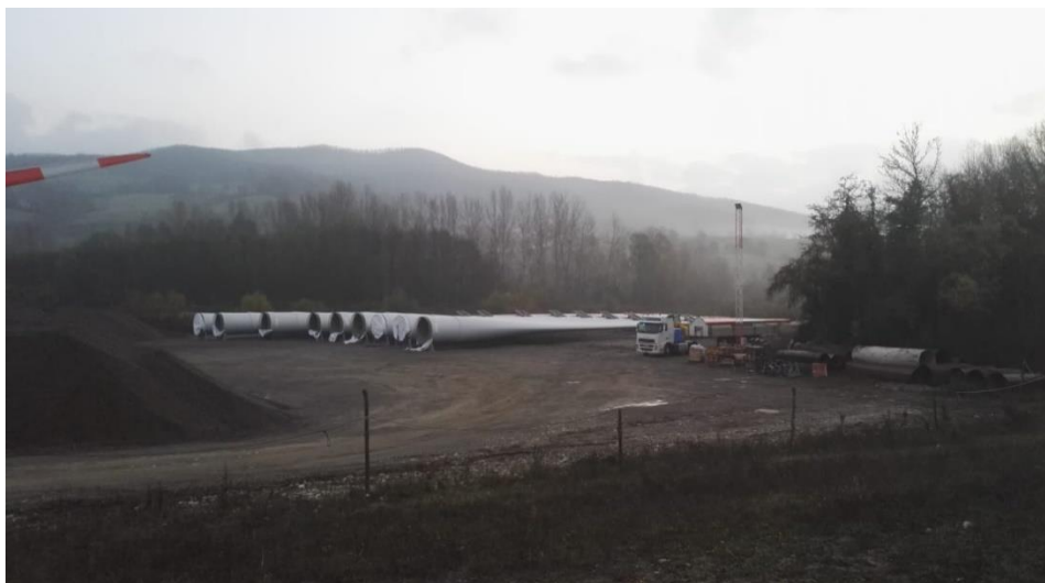
Fig. 12: stoccaggio temporaneo pale nell'area di trasbordo
