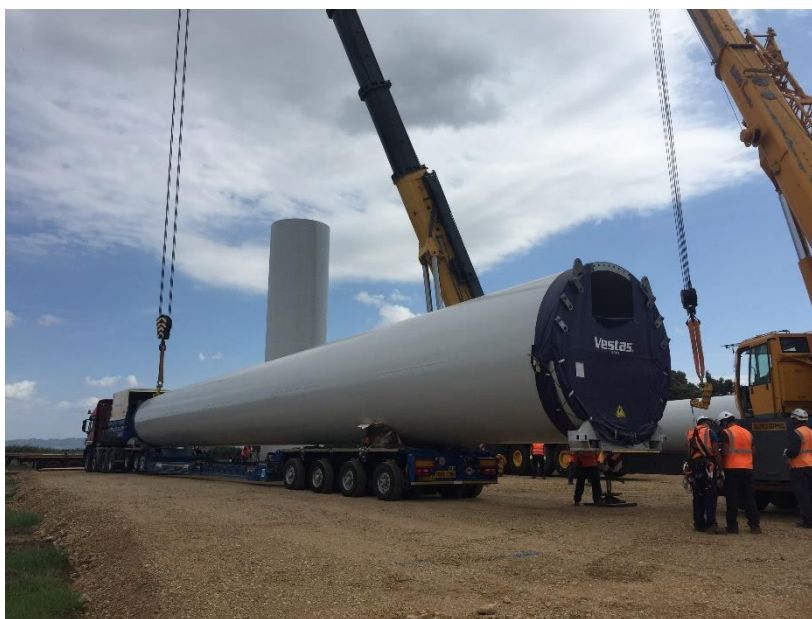
Fig. 13: scarico di tronco di torre
