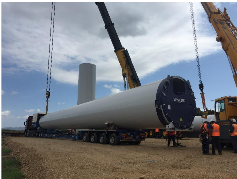
Figura 13: scarico di tronco di torre
