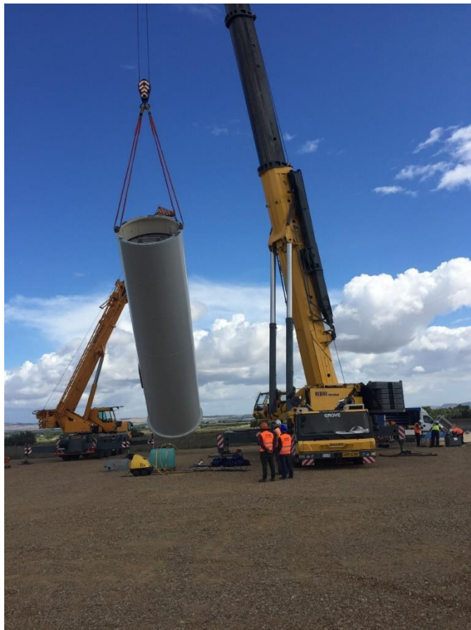
Fig. 14: sollevamento primo tronco di torre (bottom) su dado fondazione
