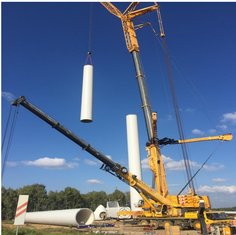
Figura 16: montaggio tronco di torre intermedio
