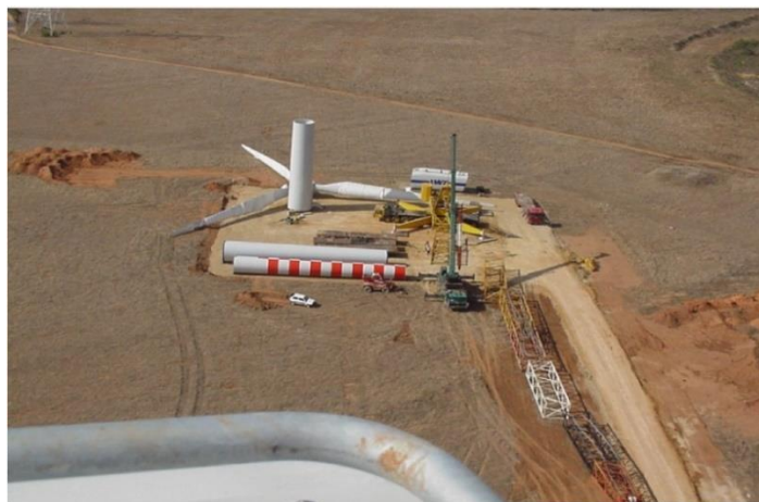
Figura 3 – Piazzola per il montaggio dell'aerogeneratore
