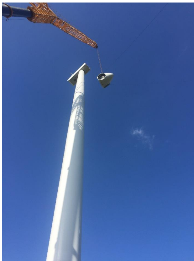
Figura 17: montaggio supporto rotore (hub)
