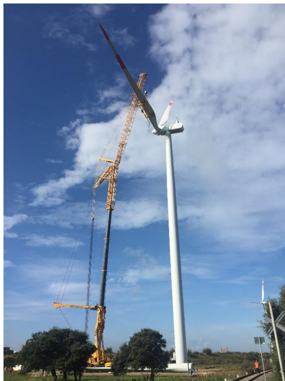
Figura 18: montaggio pale
