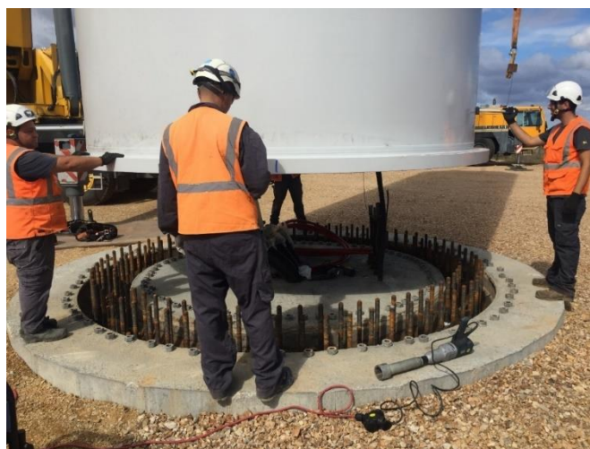
Figura 15: preparazione montaggio primo tronco di torre (bottom) su dado fondazione
