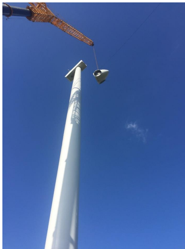
Fig. 17: montaggio supporto rotore (hub)
