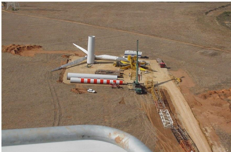
Figura 2 – Piazzola per il montaggio dell'aerogeneratore
