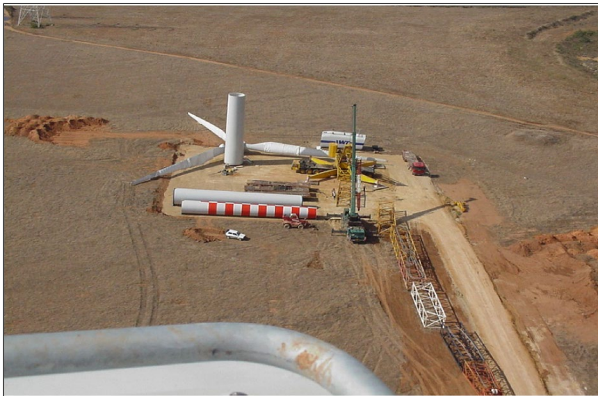
Foto 1. Piazzola per il montaggio dell'aerogeneratore
