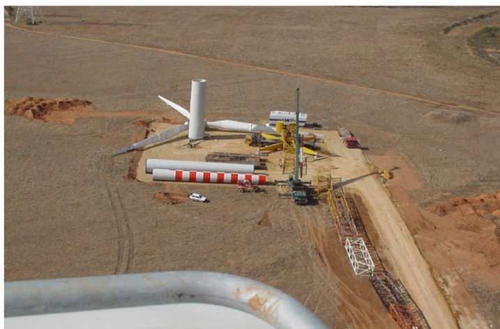
Figura 20 – Piazzola per il montaggio dell'aerogeneratore
