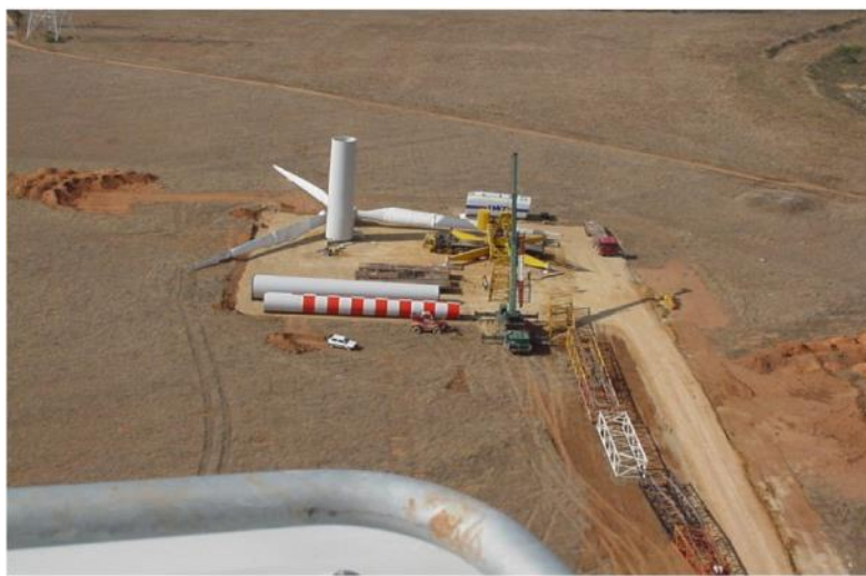
Figura 16 – Piazzola per il montaggio dell'aerogeneratore
