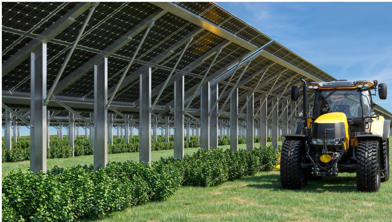
Figure 3-3: Struttura di sostegno e passaggio trattore
