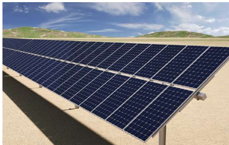
Figura 3.5: Particolare della configurazione portrait 2P
