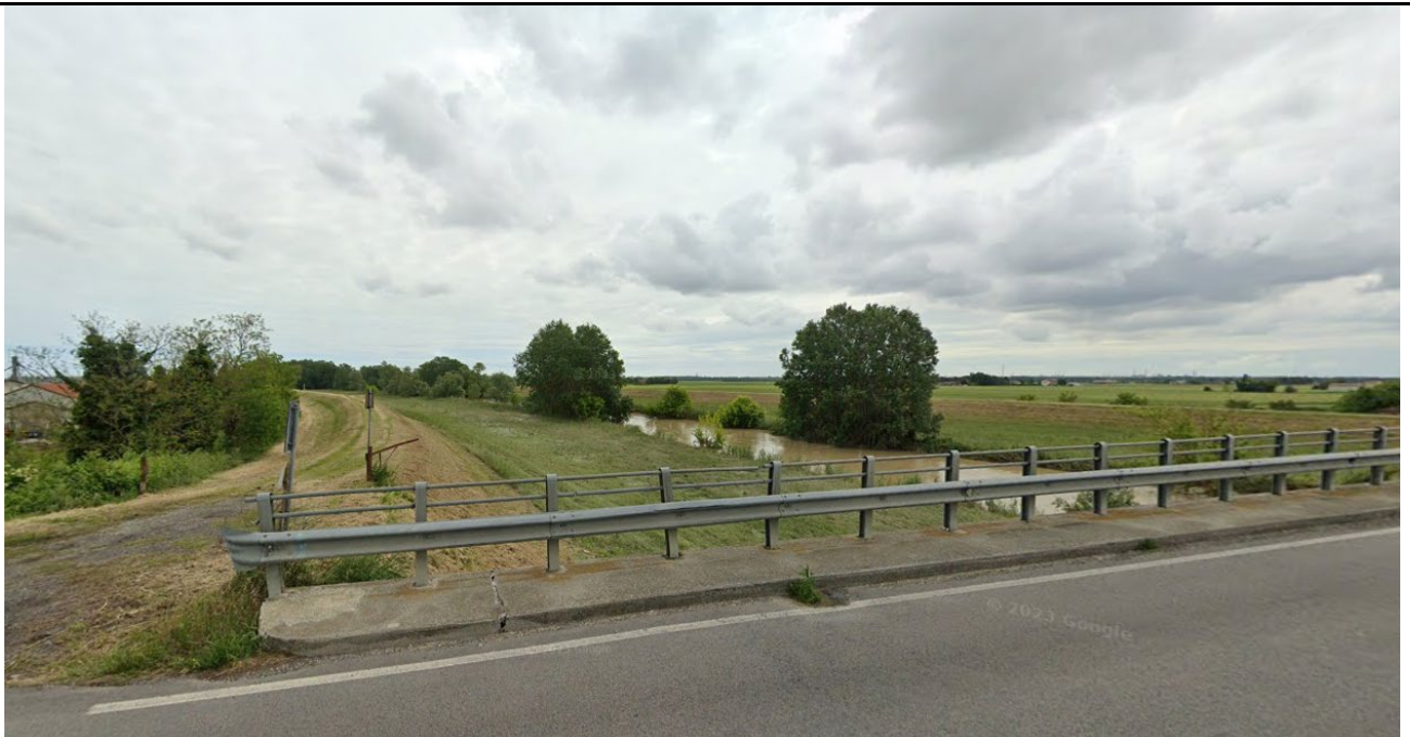
Foto panoramica dall'accesso da Via S. Alberto incrocio Via Chiavica Fenaria
