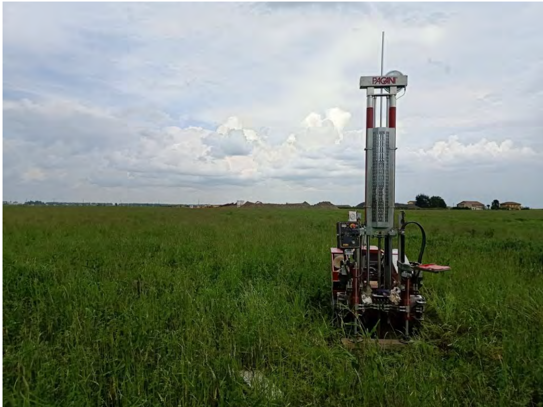
Figura 16 – Prova penetrometrica DPSH 5
