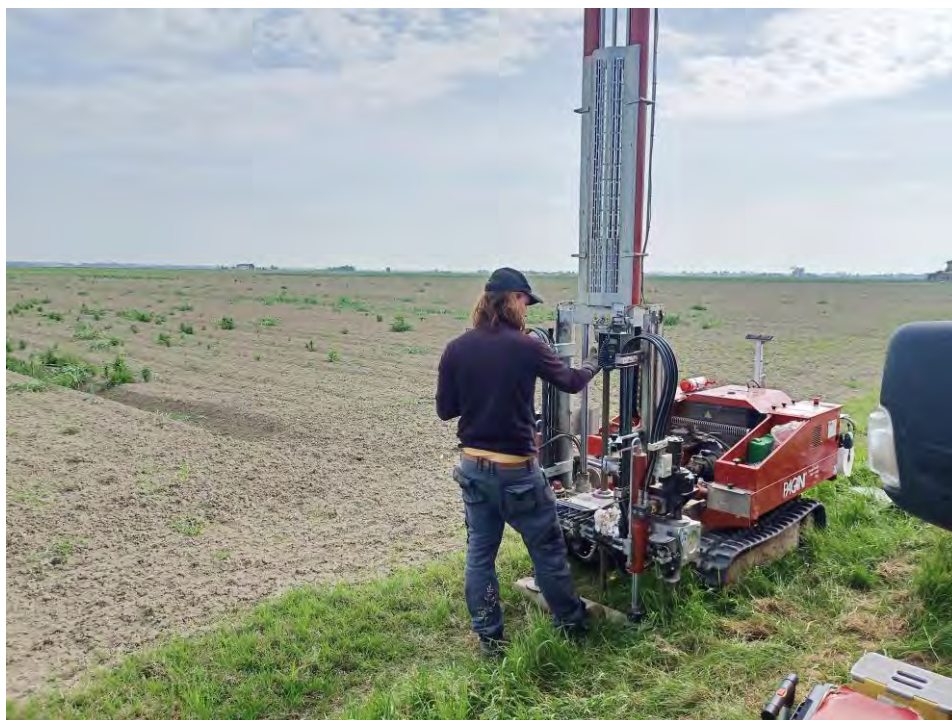
Figura 11 – Prova penetrometrica CPT1
