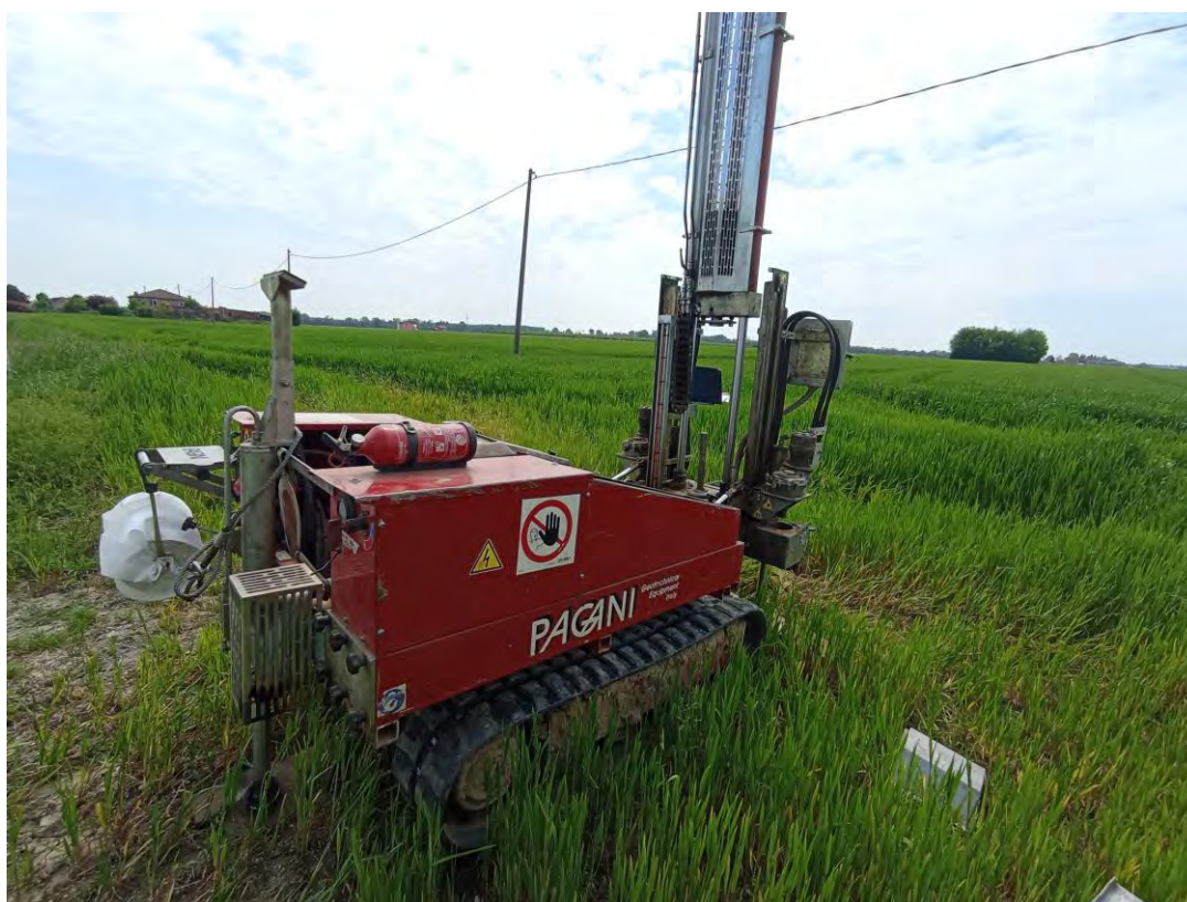
Figura 20 – Prova penetrometrica DPSH 9
