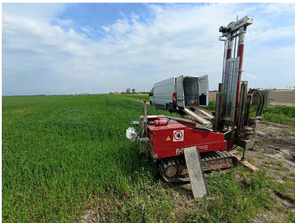
Figura 17 – Prova penetrometrica DPSH 6
