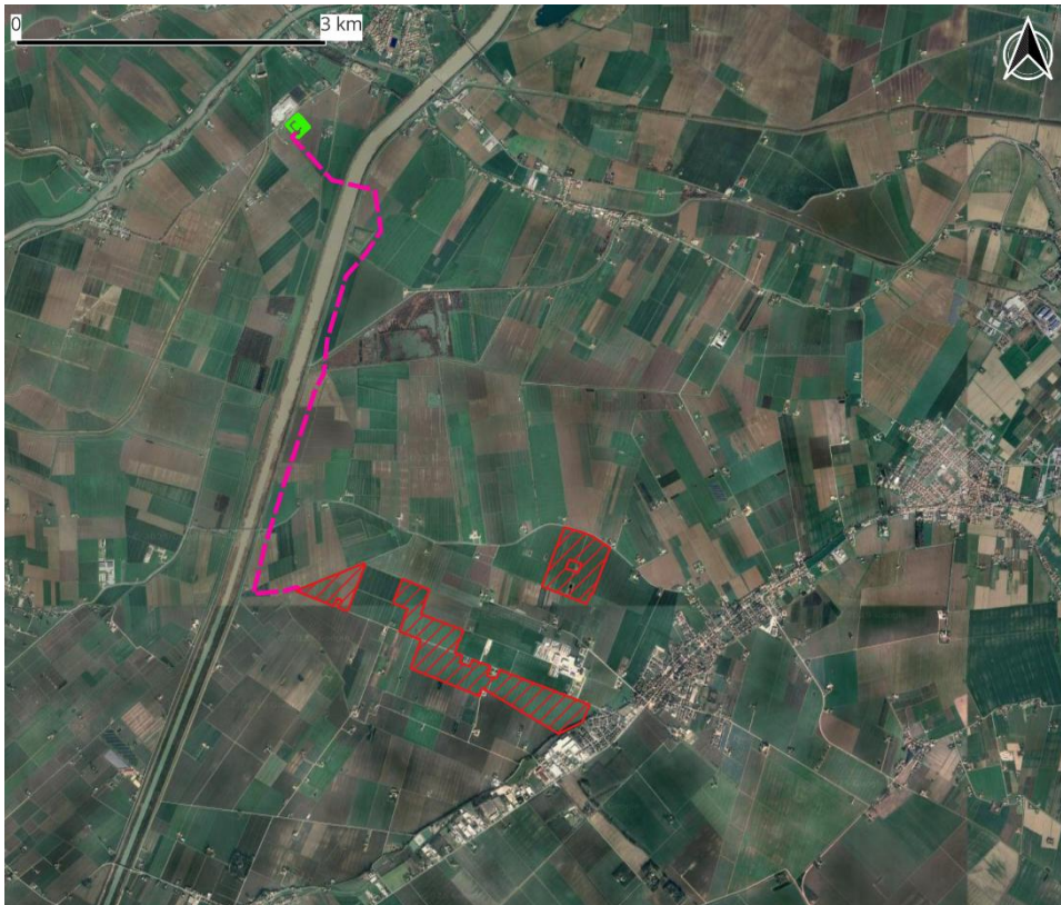
Figura 1 - Ortofoto dell'area in esame (in rosso l'area del parco FTV, in rosa le opere di connessione e in giallo la nuova SE)
