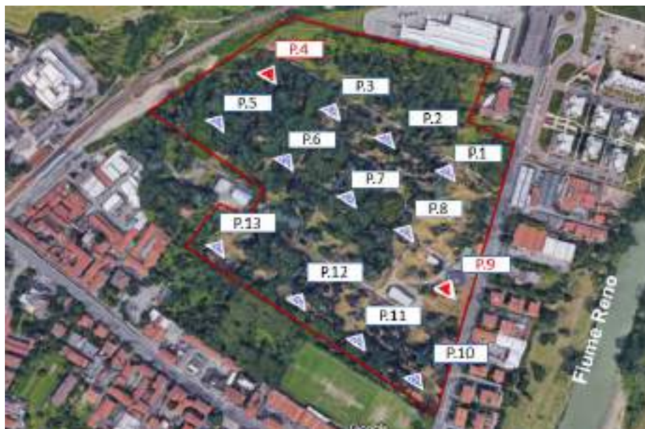
Figura 11 - area della centrale Borgo Panigale: pozzi e impianto di trattamento acque; in rosso, i pozzi fuori esercizio (fonte: Google maps)
