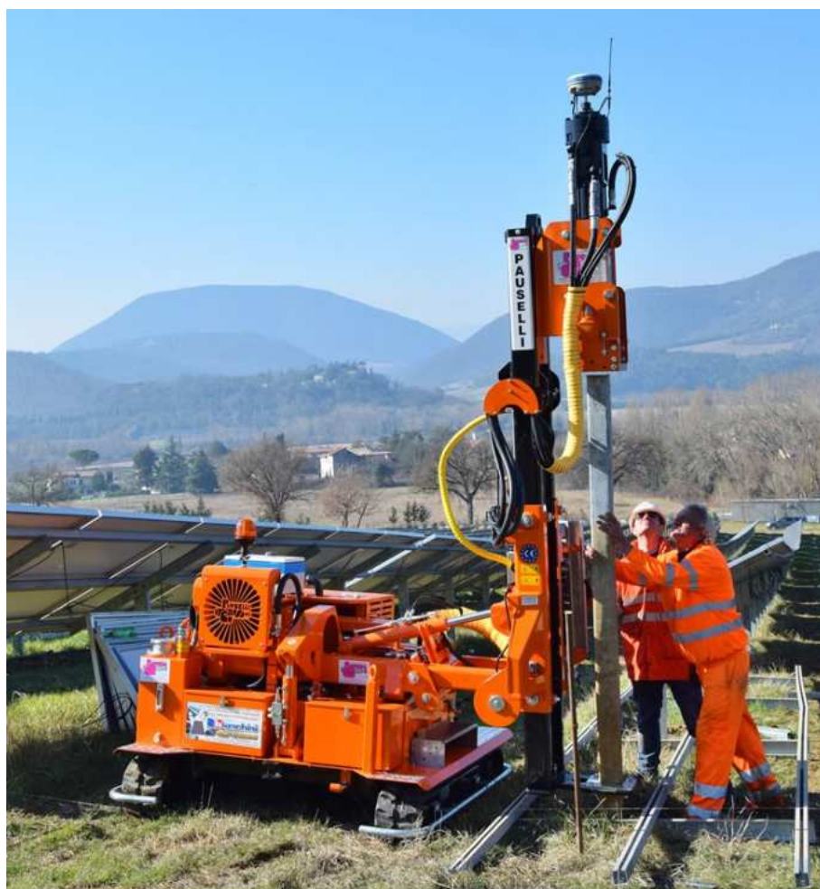
Figura 1 -infissione dei piedi della struttura monoassiale tramite macchina battipalo
