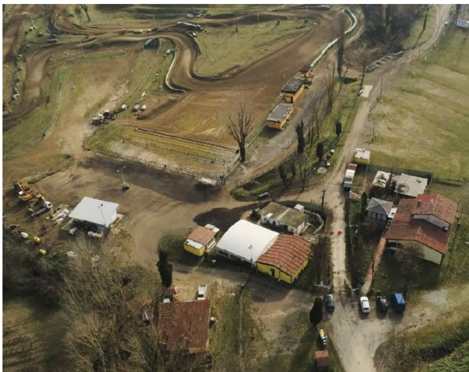
Figura 15 – Foto aerea dei fabbricati e manufatti demoliti [Fonte: P_01_Rilievo stato di fatto e documentazione fotografica del progetto generale di “Rigenerazione e ampliamento impianto sportivo e campo cross Monte Coralli”]
