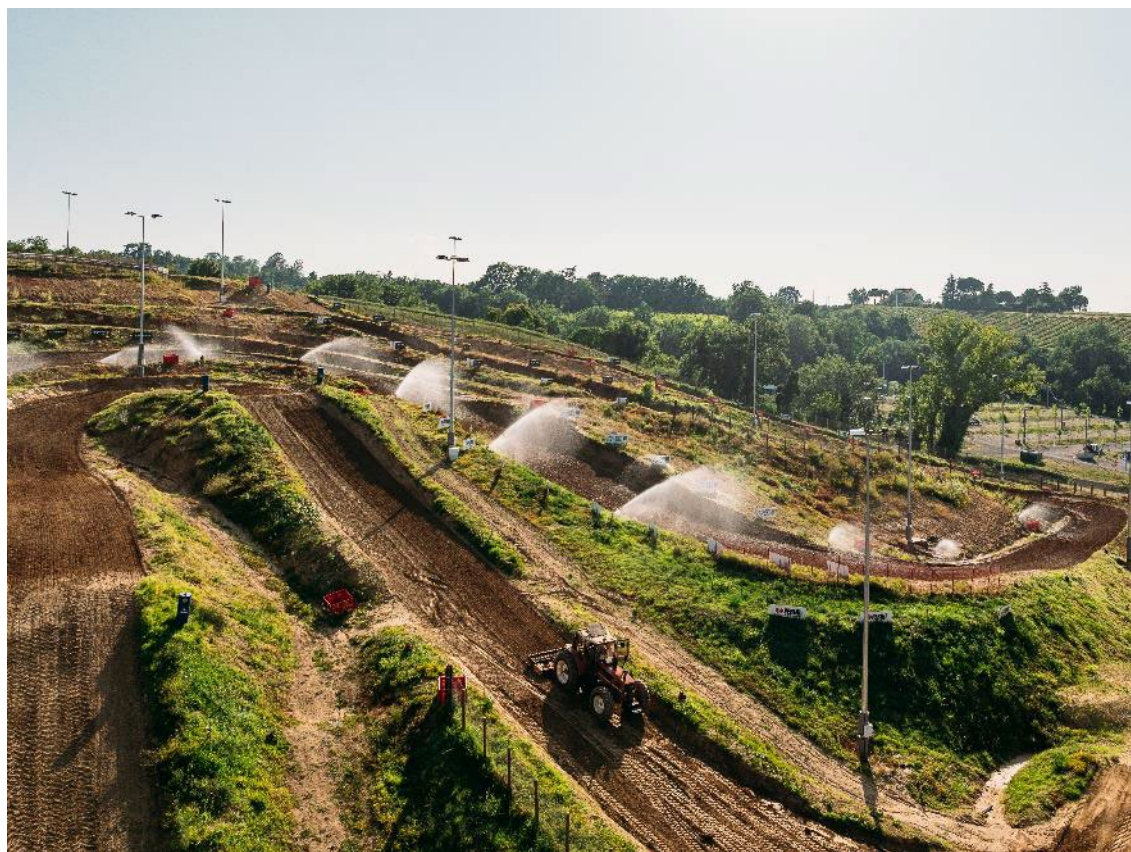
Figura 40 - Impianto di irrigazione della pista da cross
