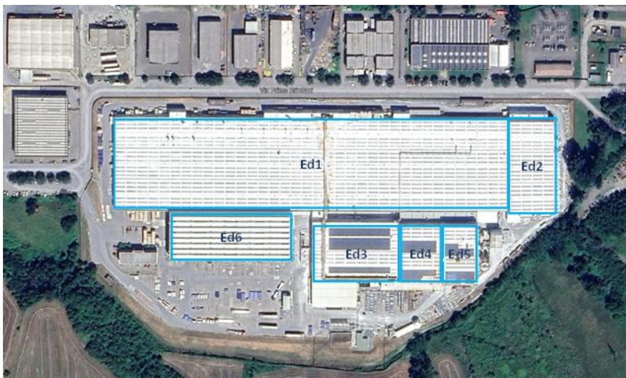
Figura 10 identificazione dei capannoni oggetto di valutazione dell'effetto edificio.
