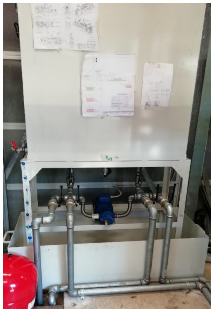
Fig.6 - Esempio di serbatoio olio di giornata con relativa vasca di contenimento
