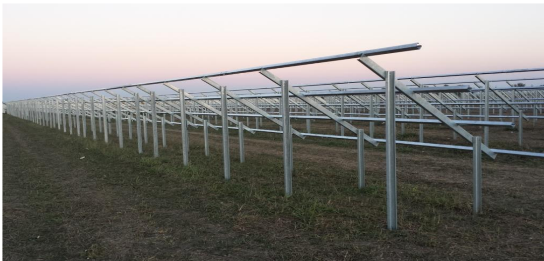
Figura 4: Stato cantiere al termine della fase lavorativa
