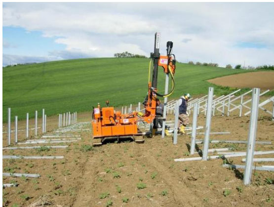
Figura 3: - Posa strutture metalliche di fondazione
