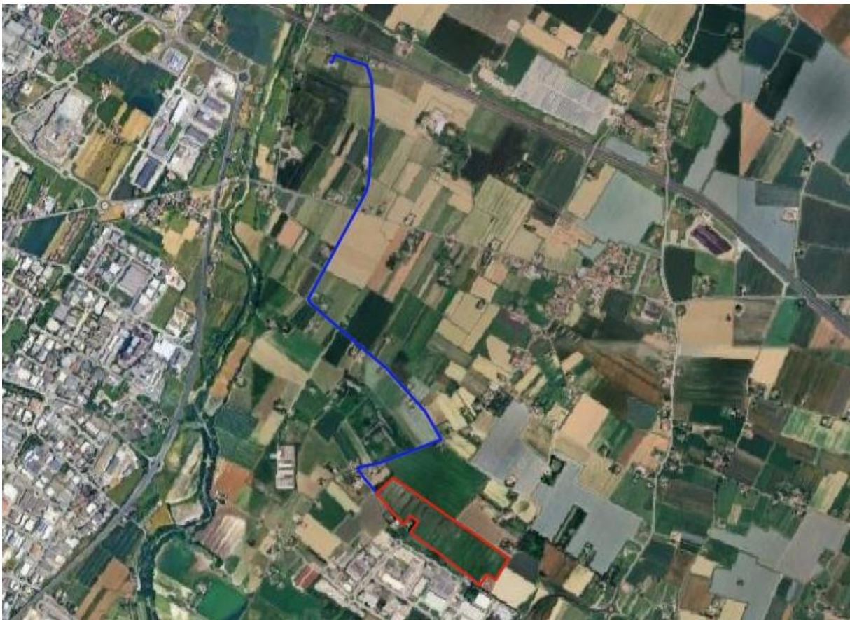
Figura 1.2 - Foto aerea dell'area interessata dall'impianto fotovoltaico (Fonte: Google earth)
