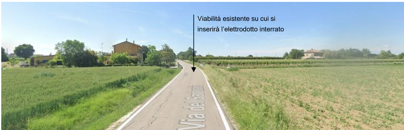
Figura 4.13 - Immagine della viabilità su cui insisterà l'elettrodotto interrato – Via del Santuario (fonte: Google Maps)
