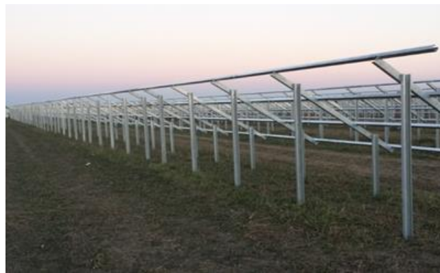
Figura 3-14 - Stato cantiere al termine della fase lavorativa
