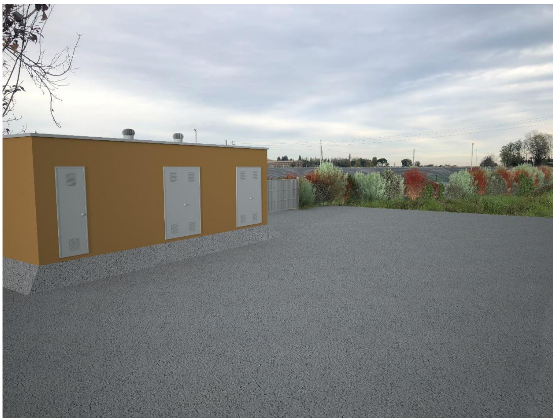
Figura 5-16 – Vista n. 3 post operam
