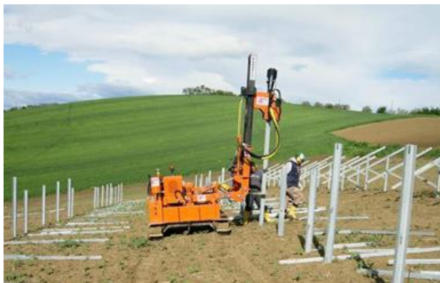
Figura 3-13 – Messa in opera delle strutture di sostegno
