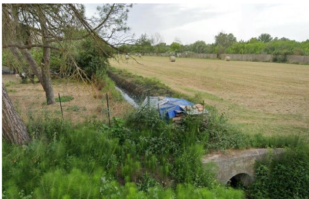
Figura 5-4 – Scolo Tassinara Vecchia nel punto di attraversamento in TOC in via Bianco da Durazzo
