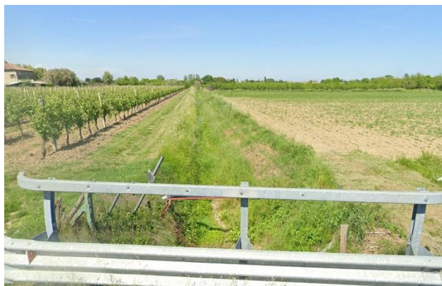
Figura 5-5 – Scolo Tassinara Vecchia nel punto di attraversamento in TOC in via Santuario
