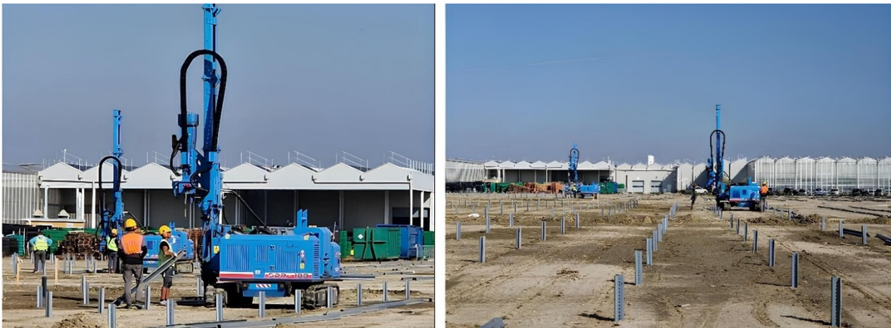
Figura 19: Lavorazione di infissione dei pali con macchina battipalo.
