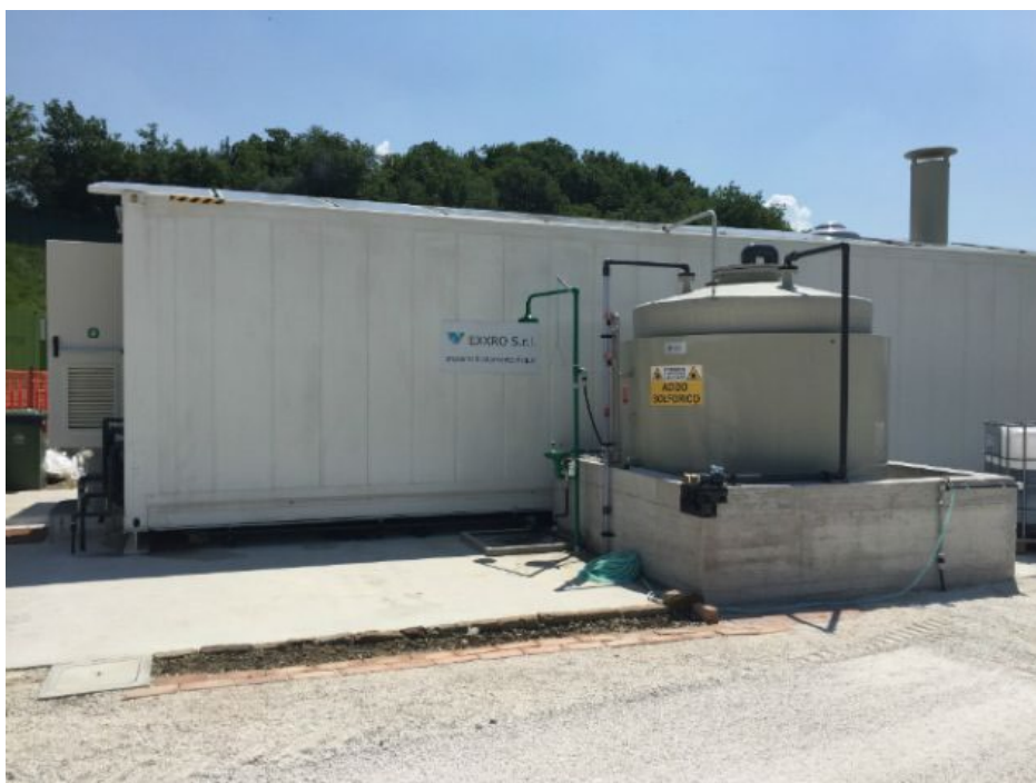
Figura 28 - Esempio di installazione di un impianto a osmosi inversa
