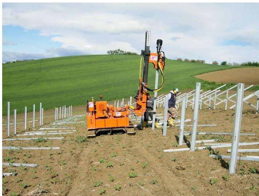
Figura 4-2: Macchinario per l'infissione dei pali di sostegno mediante battitura.
