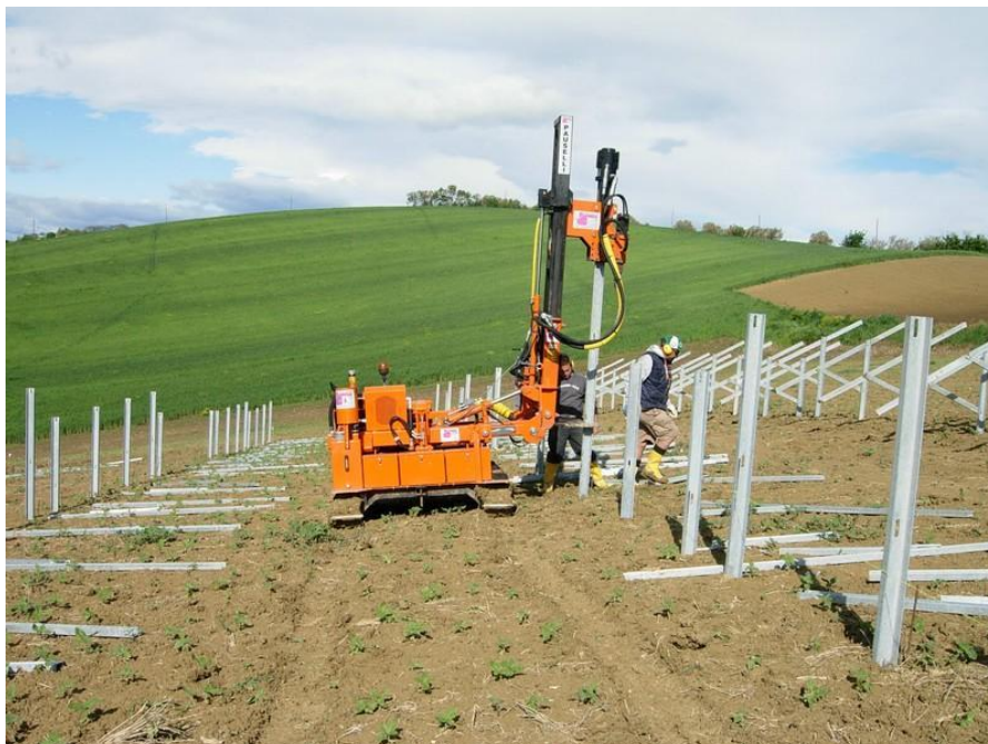
Figura 5. Esempio macchina battipalo per il fissaggio delle strutture
