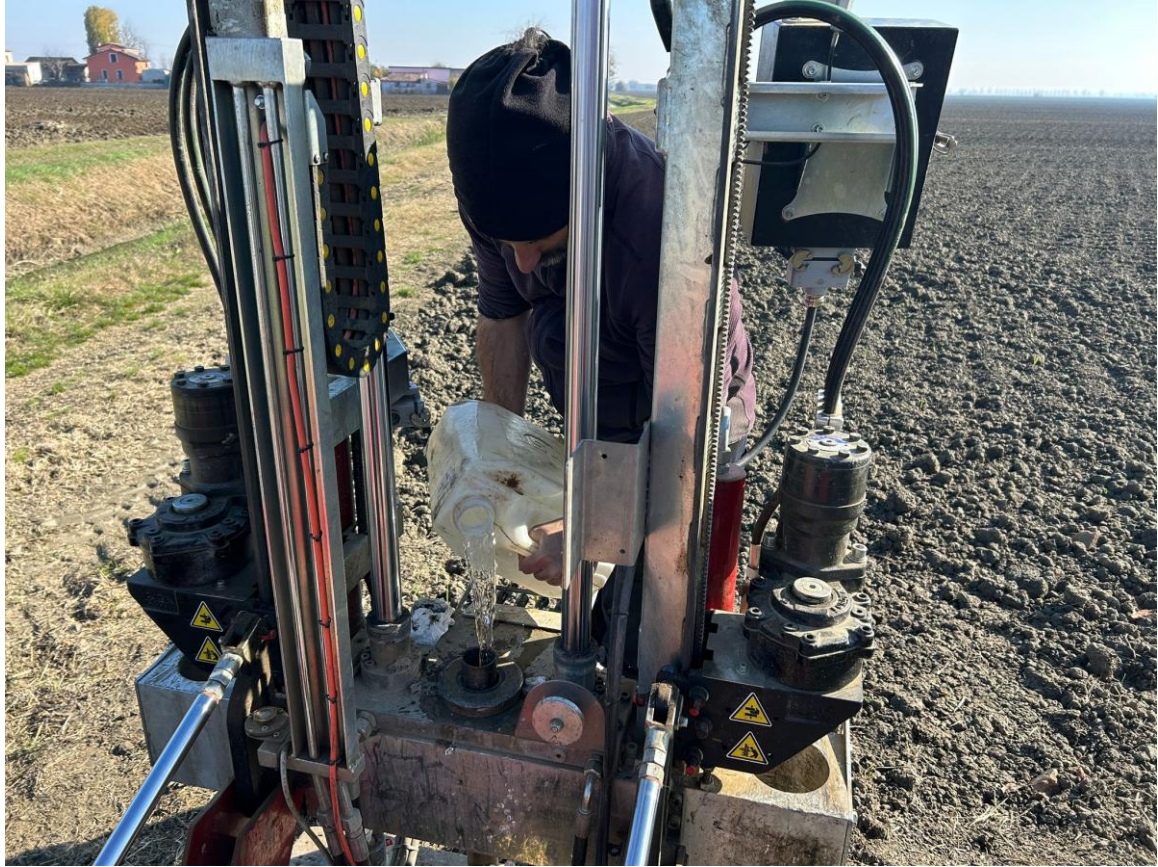
Figura 26– Prova di permeabilità
