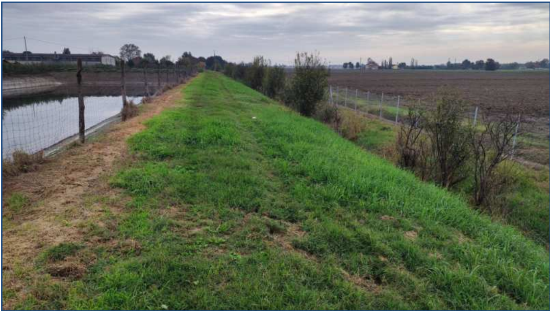
Foto 7 – Argine perimetrale esterno sul lato sud ripreso da ovest verso est. A sinistra la recinzione di sicurezza del lagone e a destra il fosso di guardia e la recinzione di protezione dell'allevamento.
