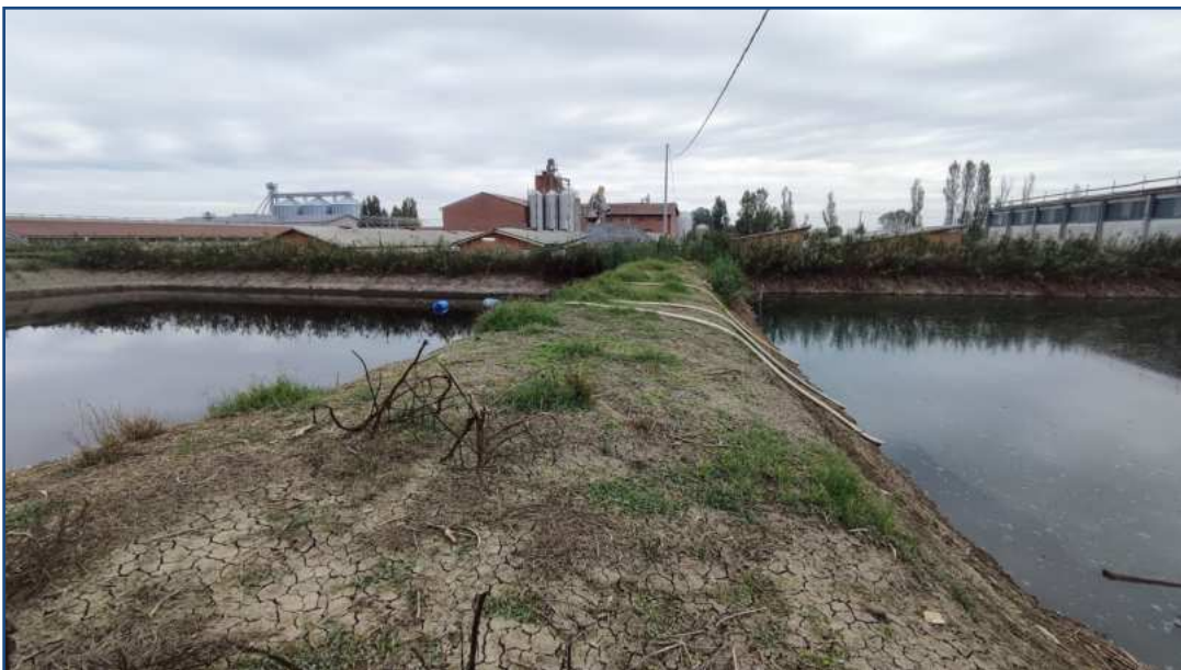
Foto 2 – Setto arginale intermedio di separazione tra la vasca est, a destra, e la vasca centrale, a sinistra, ripreso dal lato sud. Sullo sfondo i fabbricati aziendali.
