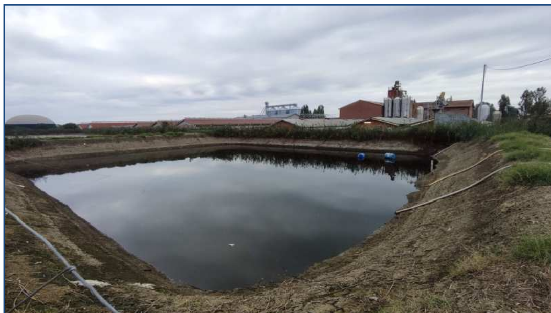
Foto 3 – Veduta interna della vasca centrale ripresa dall'angolo sud-est.
