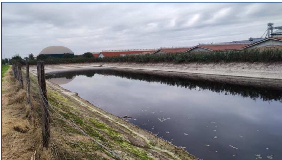
Foto 4 – Veduta interna della vasca ovest ripresa dall'angolo sud-est.
