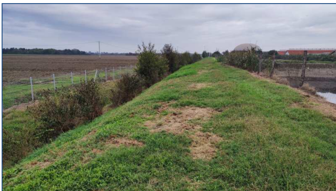
Foto 6 – Argine perimetrale esterno sul lato sud ripreso da est verso ovest. A destra è visibile la recinzione di sicurezza del lagone e a sinistra il fosso di guardia e la recinzione di protezione dell'allevamento.
