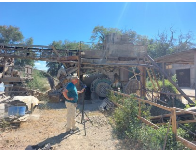
Impianto di lavorazione sabbia e ghiaia
