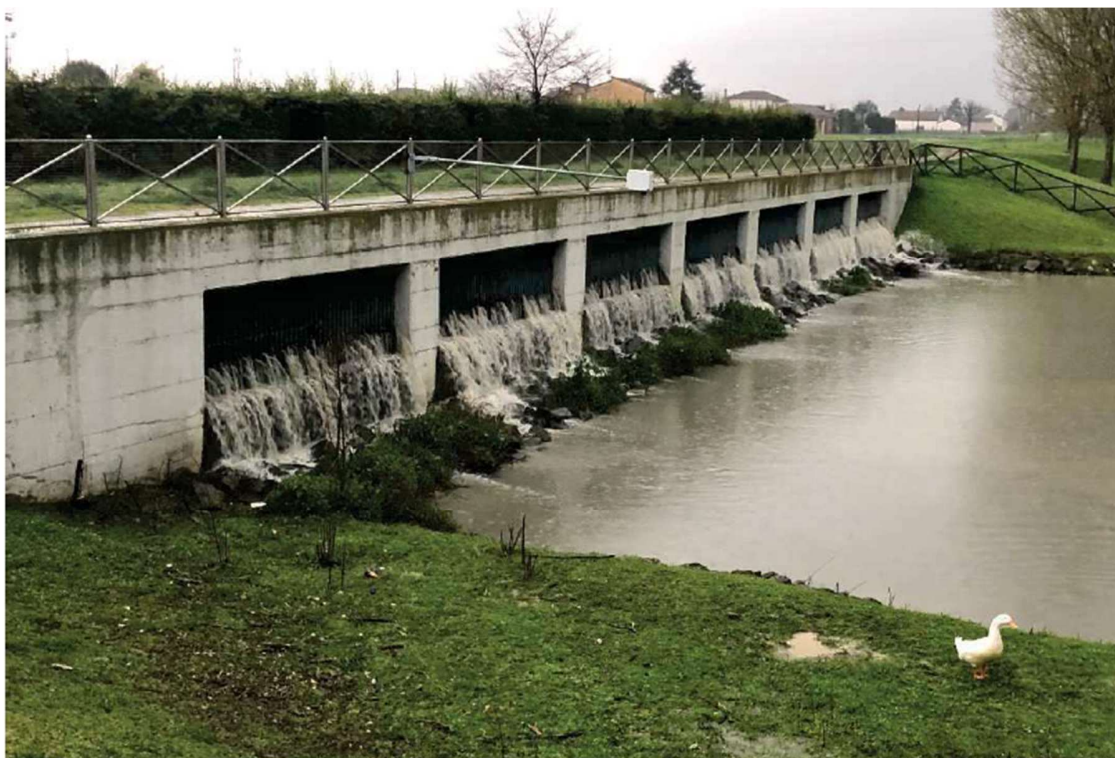
Fig. 18: scaricatore di piena esistente con griglie interne
