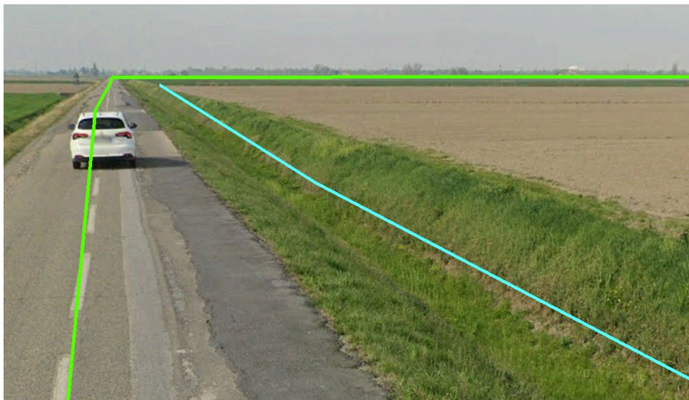
Figura 57 – “Parallelismo 2” del cavidotto tra cabine R2 e R3 con canale di superficie
