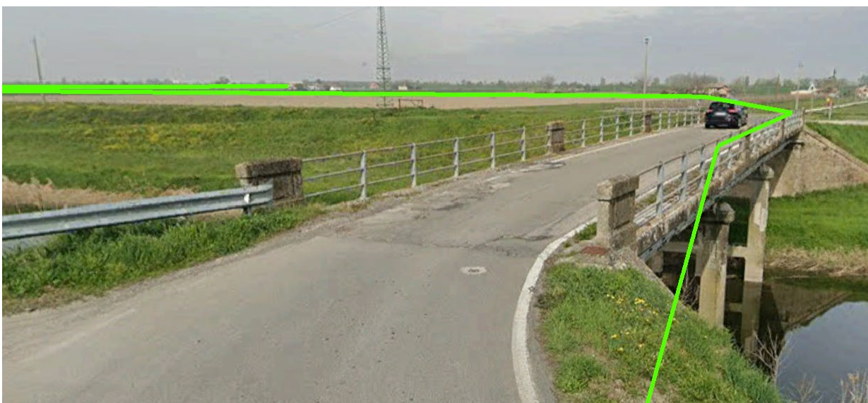
Figura 45 – Interferenza "Ponte 4" risoluzione staffaggio sul ponte
