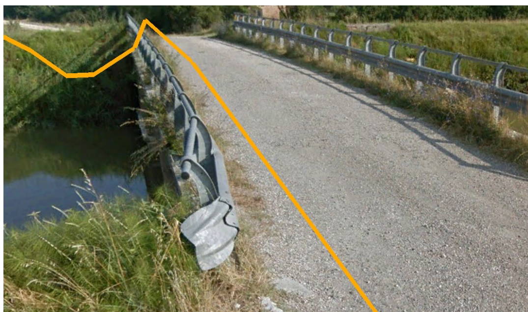
Figura 29 - Particolare attraversamento ponte in via Covazzi
