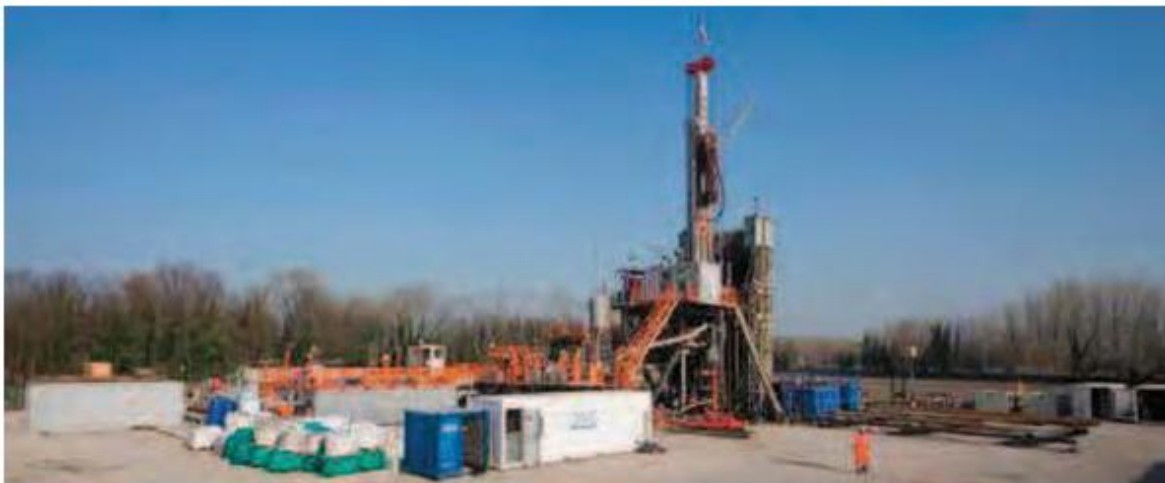
Figura 3 - Perforazione di un pozzo esplorativo in Pianura Padana (archivio PoValley Energy)
