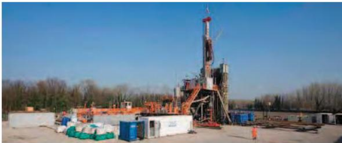
Figura 73 - Perforazione di un pozzo esplorativo in Pianura Padana (archivio PoValley Energy)
