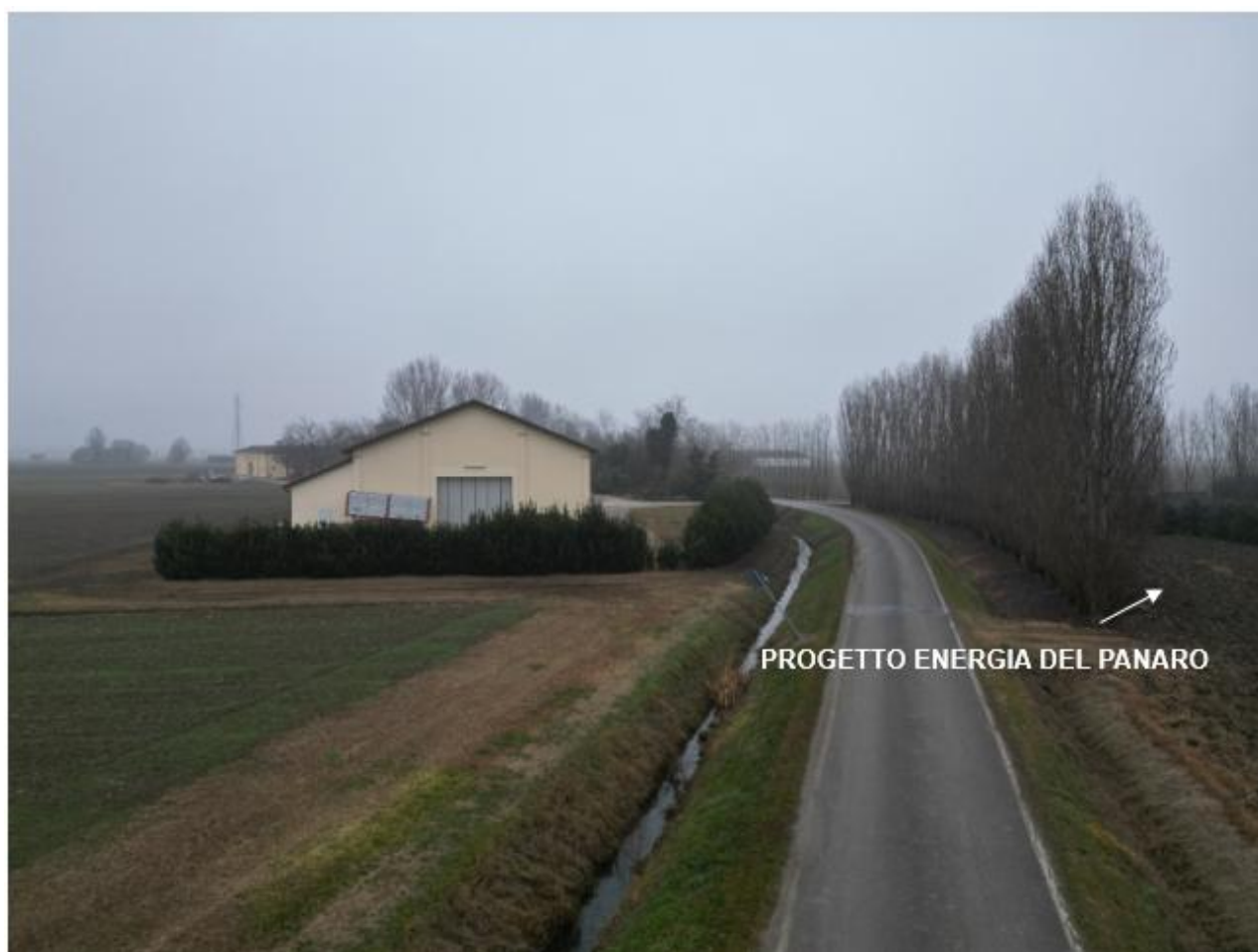
Figura 9 - Rilievo fotografico tramite drone
