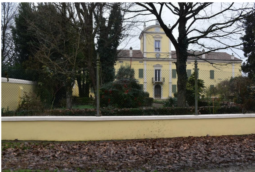
Figura 5 - Vista frontale del Casino dei vecchi
