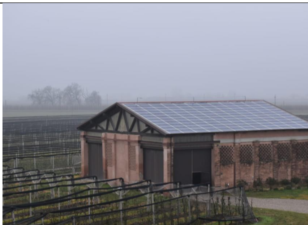
Copertura fotovoltaica, stima 50 kW
