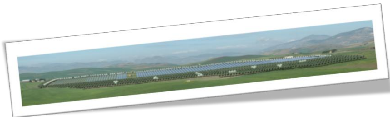
Figura 30 - Impianto fotovoltaico da 5 MW, "Heliospower", Monreale /(PA) 2010
