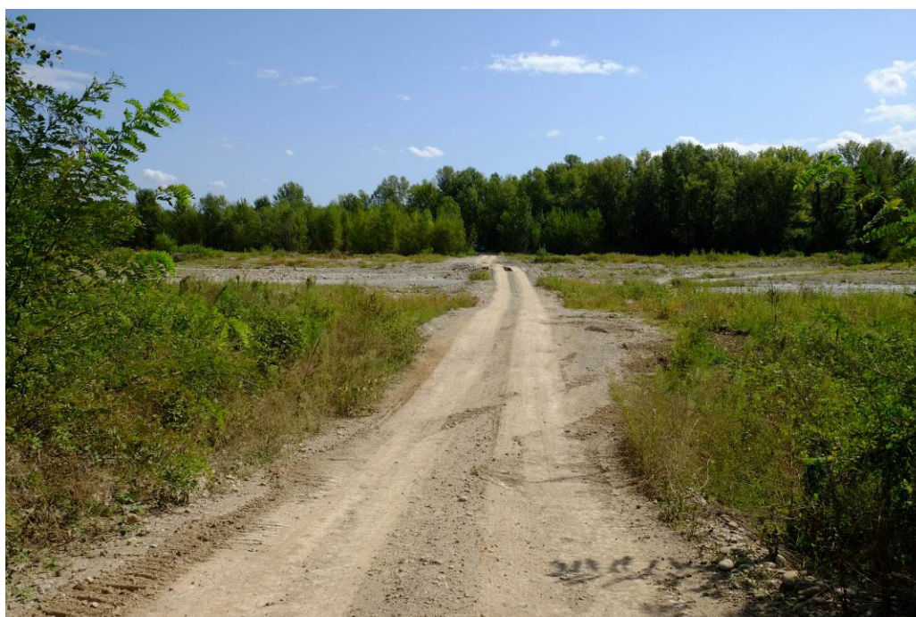
Foto 4: Pista di cantiere e guado sul torrente Enza
