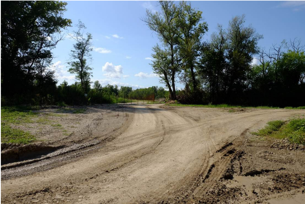
Foto 7: Pista di cantiere dell'area estrattiva Polo G6 "Enza Sud" Stralcio M1
