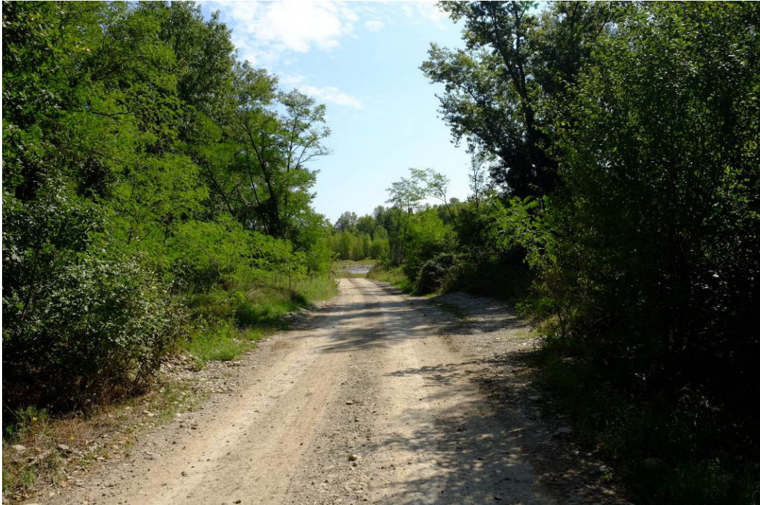
Foto 1: Pista di cantiere per il trasporto degli inerti all'impianto di lavorazione di Barcaccia
